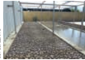
Station d'épuration industrielle
