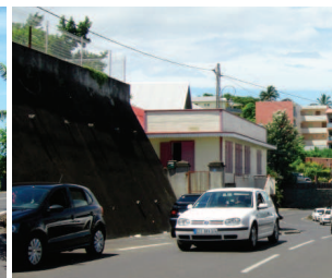
Construction au-dessus de la route, mur de soutènement
