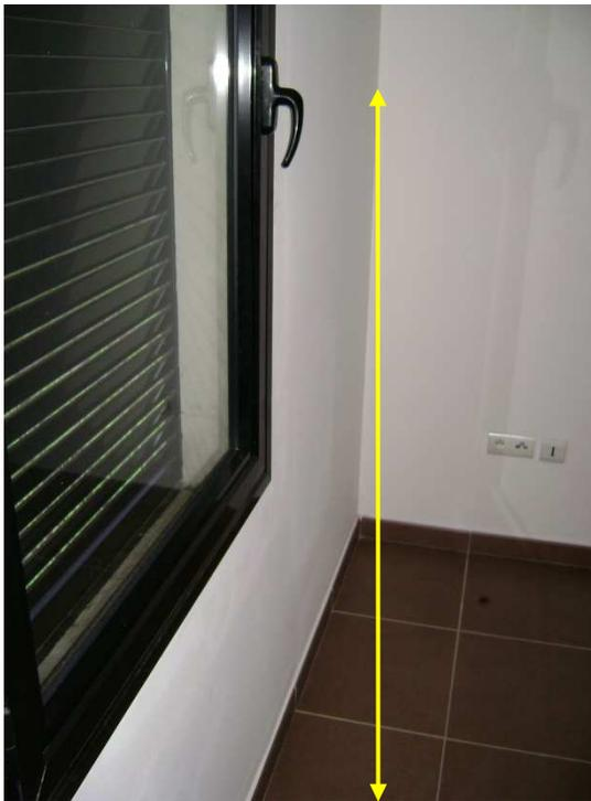
Commande d'ouverture de fenêtre inaccessible
