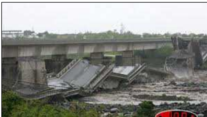
Photo de l'effondrement du pont de la Rivière Saint-Etienne suite au cyclone Gamède en février 2007 (source : ipreunion)
