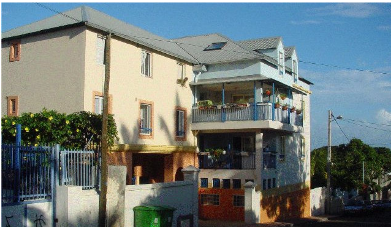
Opération Portland à Saint-Pierre - SHLMR
