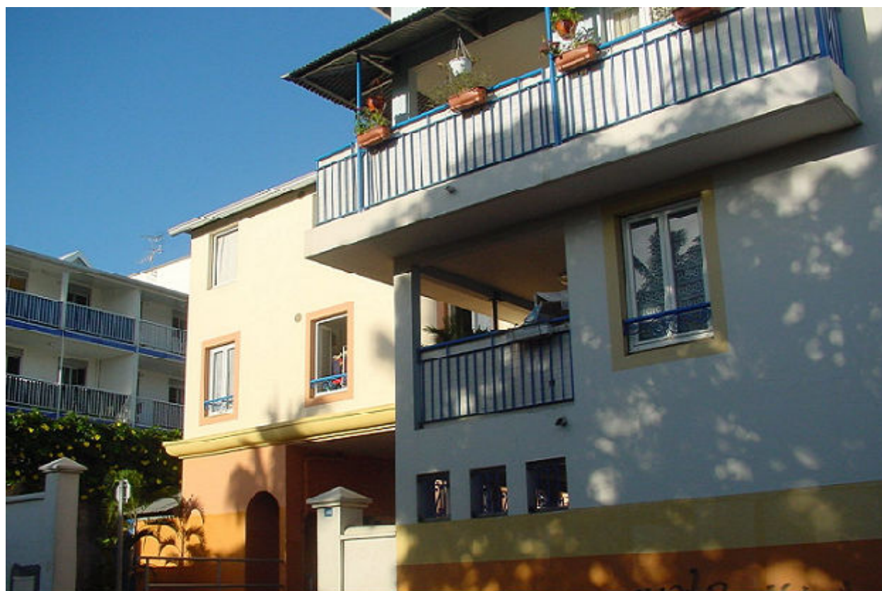
Opération Portland à Saint-Pierre – SHLMR
