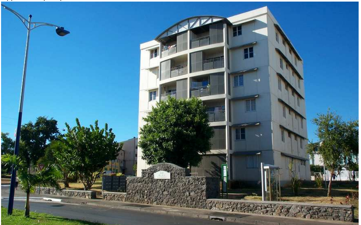
Opération de réhabilitation Chaudron 4 Saint-Denis - SIDR
