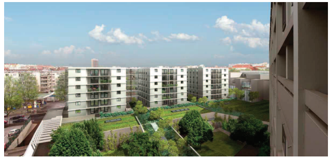
Lyon Bachut - Construction d'une médiathèque, 80 logements, 1 supermarché - Opac du Rhône, Ville de Lyon, Meunier Rhône-Alpes - 10 000m 2 - Chef de projet AABD
