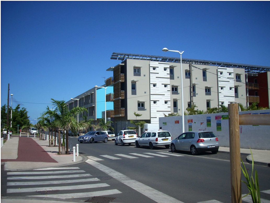
Résidence Yoshito « En souvenir de François le merveilleux peintre architecte », François Hennequet Architecte – Direction Départementale de l'Équipement
