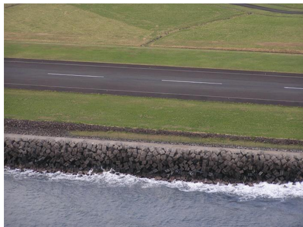
Figure 7 : Photos du port de Sainte-Marie et des aménagements de type « tétrapodes » présent sur le cordon de galets au-devant de l'aéroport Rolland Garros à l'ouest de la commune de Sainte-Marie (Campagne Morpholitt, De la Torre, 2004)
