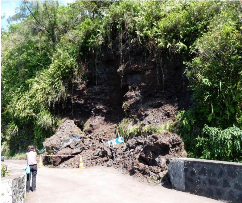
Figure 13 : Éboulement sur la RN2 du 11 octobre à l'émorce est du rempart de Sainte-Rose dans le secteur d'Îlet Leroux (Note Technique BRGM/SGR/REU – NT 2009-88 – V2<sup>4</sup>)
