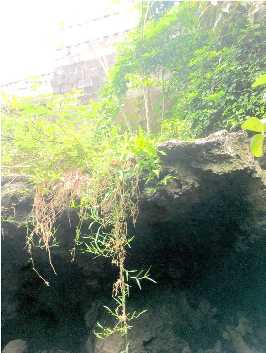
*Figure 22 : Sous-cavage observé sur la Ravine Bonin au pied d'une habitation*
