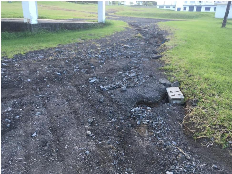
Figure 21 : Érosion due à un ruissellement important Place des Fêtes à Piton Sainte-Rose
