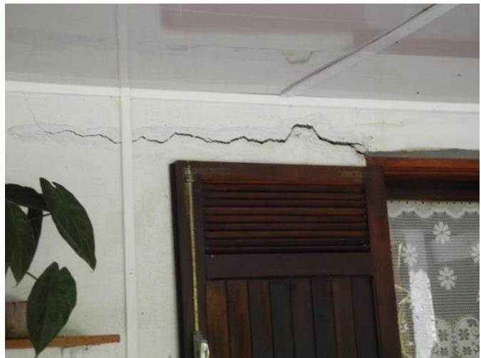
Figure 29 : Indices d'instabilité observés dans la zone du glissement actif de Mare à Goyave
