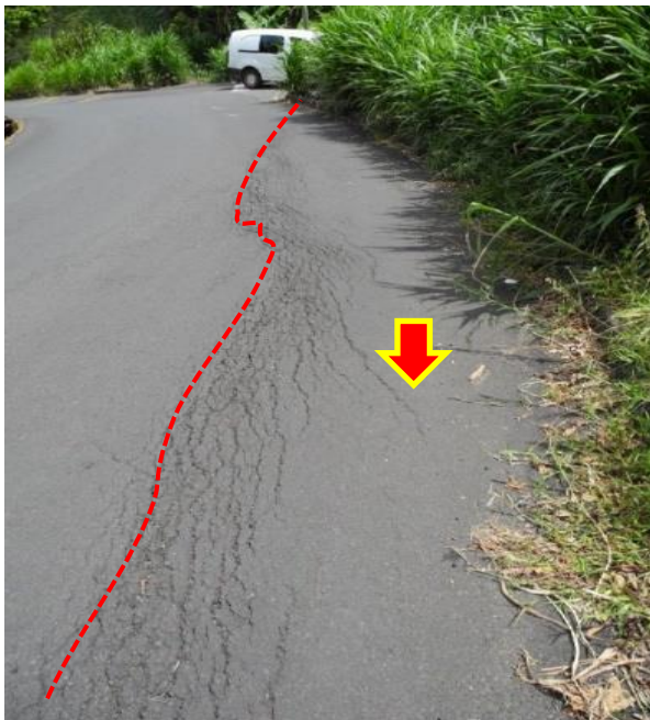
Figure 29 : Indices d'instabilité observés dans la zone du glissement actif de Mare à Goyave
