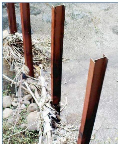
Exemple de piège à embâcle en pieux IPN
