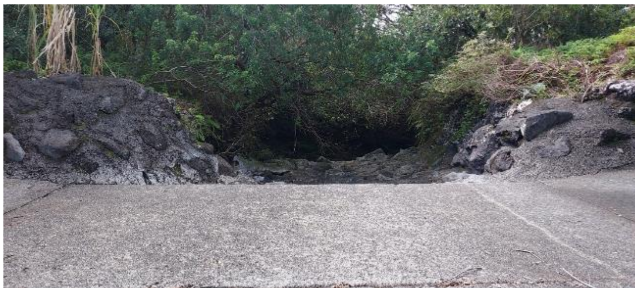
Figure 18 : Ouvrage de déviation de la ravine Valentine dans la Grande ravine Glissante
