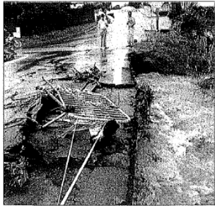
Le petit pont reliant Bras-Mousseline et Bras-des-Chevrettes a été sérieusement endommagé.
