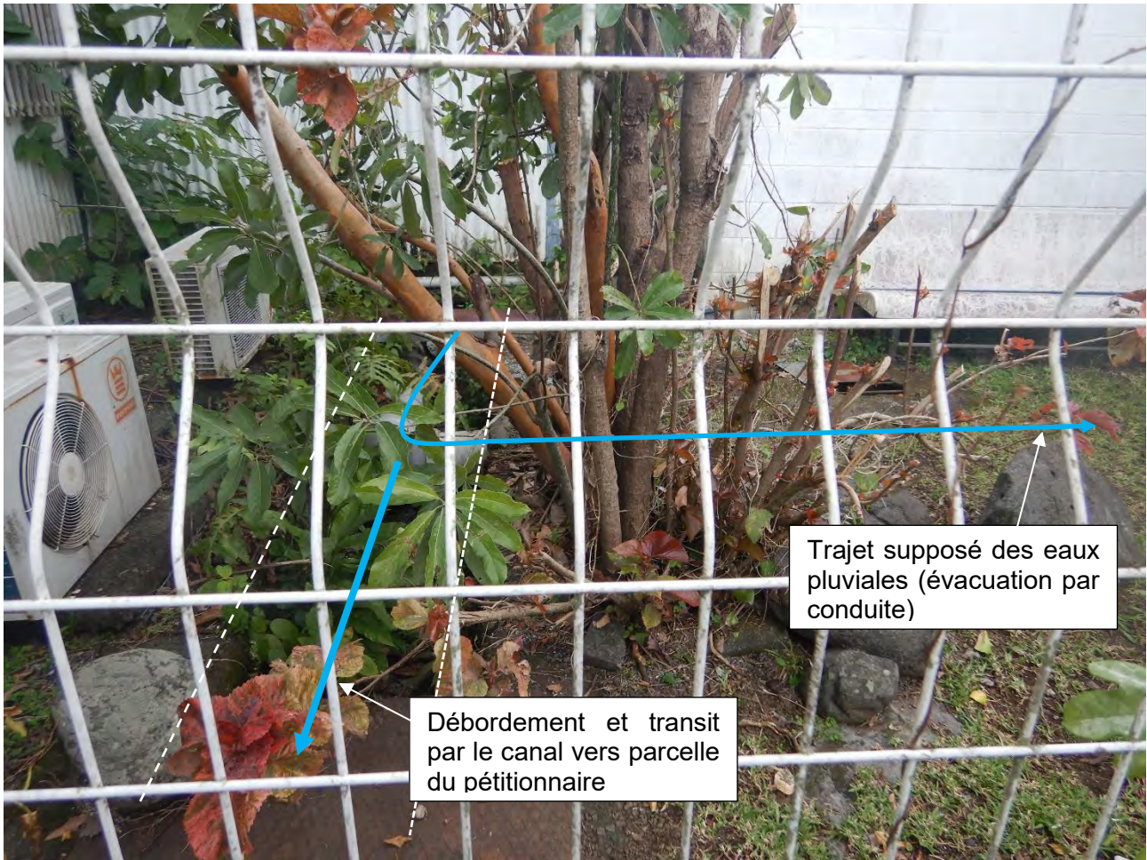
Figure 11 – Vue sur la parcelle voisine montrant la présence du canal et de la conduite d'évacuation des eaux pluviales
