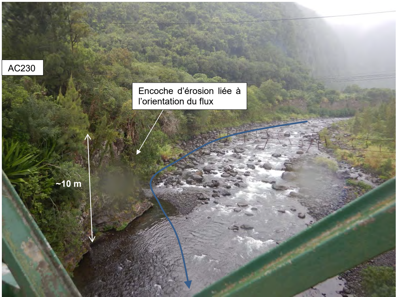
Figure 7 – Conditions d'écoulement de la rivière du Mât au niveau de la passerelle d'Ilet Payet montrant la déviation du flux par l'éperon rocheux formé par la terrasse en rive droite.
