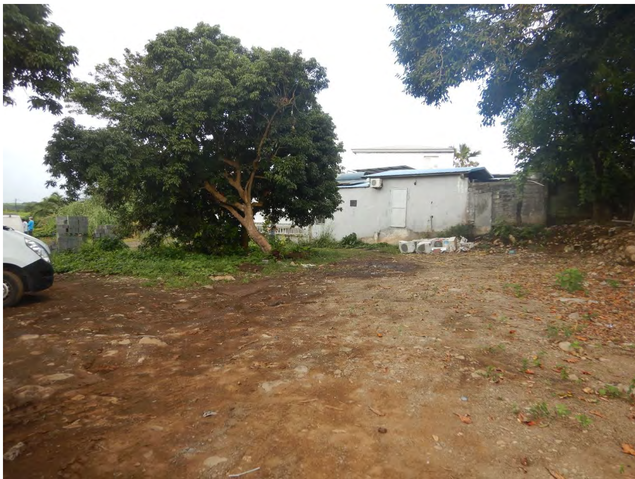
Figure 10 – Plate-forme remblayée en arrière de la berge
