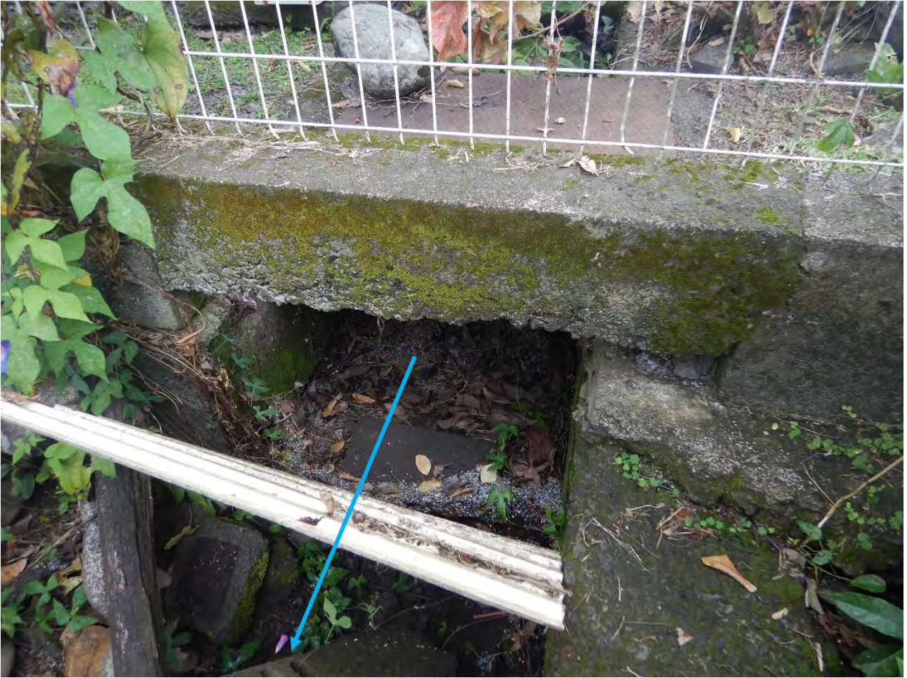
Figure 12 – Ouverture dans le muret maçonné entre parcelle voisine et la parcelle des requérants
