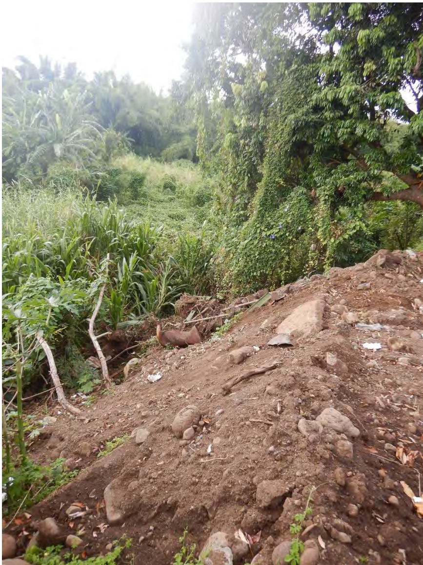
Figure 9 – Remblai non compacté en limite de berge au droit de la parcelle AE266
