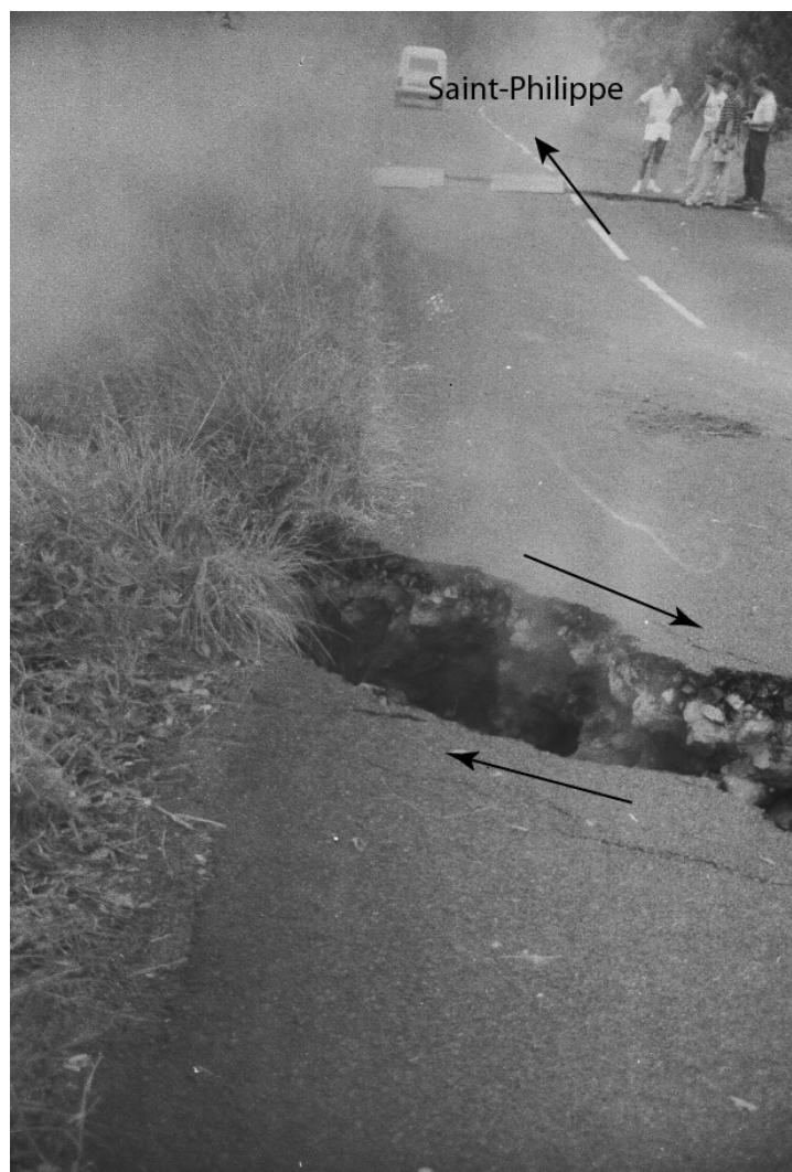
Figure 3: Fractures dans la RN 2 liées à la propagation du magma en sub-surface vers la Pointe de la Table. L'ouverture totale des fractures était de 105 cm et le décalage latéral, vers l'est, de la partie nord est de 41 cm (Delorme et al., 1989). Photo: Philippe Mairine.
