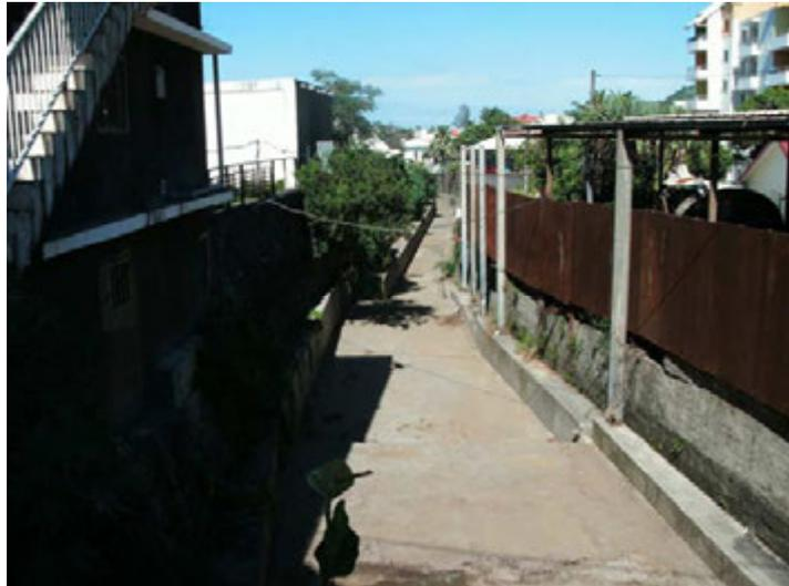
*Photo n°27 – FOND BETONNE AVEC SEUILS EN AVAL DE LA PASSERELLE OH 6*
