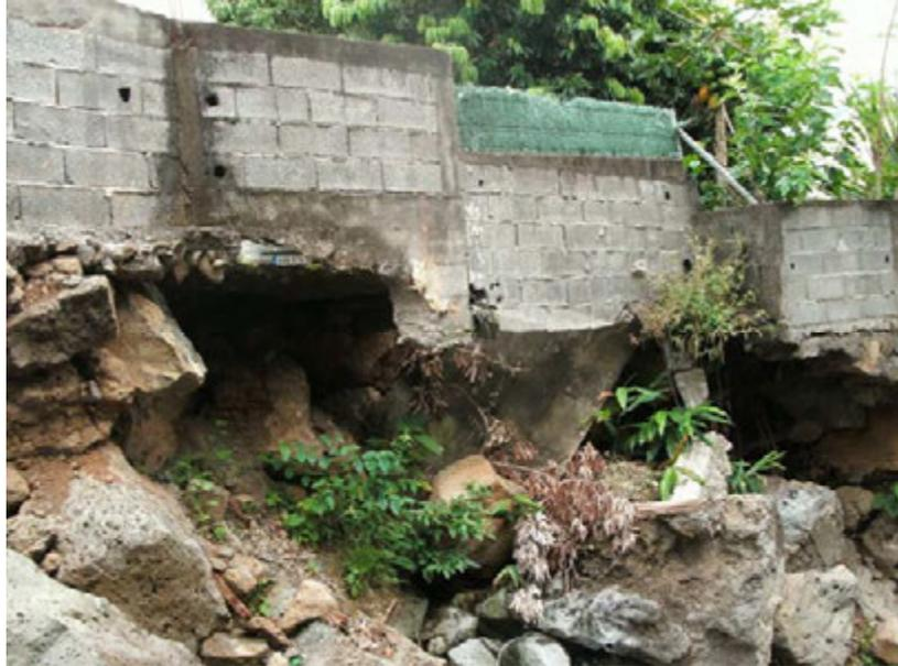
*Photo n°31 – AFFOUILLEMENT DU MUR DE CLOTURE ET DE LA COUR DE L'HABITATION RIVE GAUCHE AU PK 1,7*
