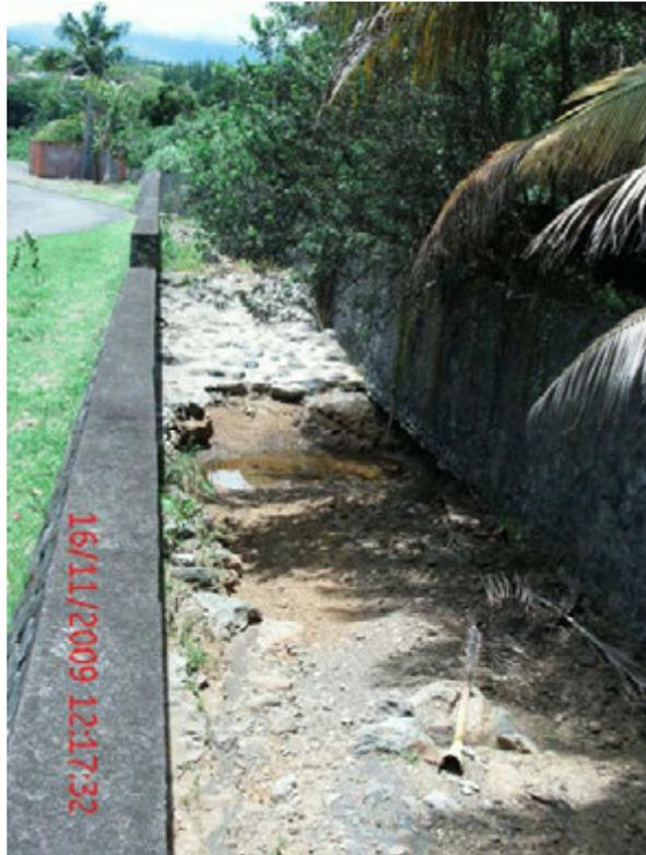
*Photo n°11 – AFFOUILLEMENT DES MURS D'ENDIGUEMENT ET INCISION DU LIT
