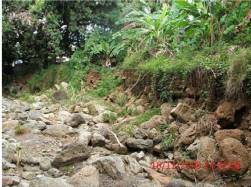
*Photo n°29 – EROSION DE BERGE RIVE GAUCHE AU PK 1,850*
