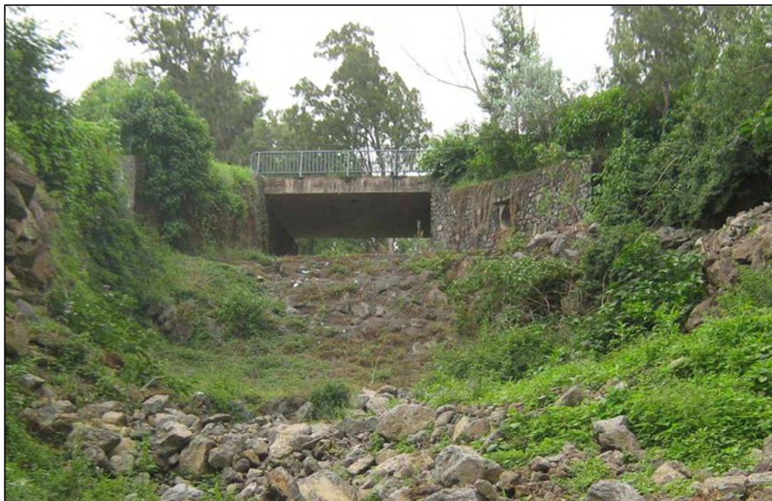
Photo 1 VUE AVAL DE L'OUVRAGE
