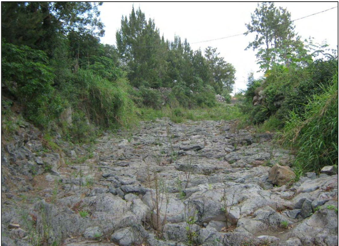
Photo 2 FOND DU LIT DE LA RAVINE BLANCHE A PROXIMITE DE L'OUVRAGE
