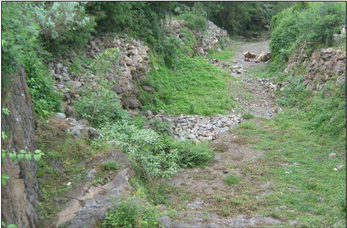
Photo 3 BERGES DE LA RAVINE BLANCHE A L'AVAL DE L'OUVRAGE
