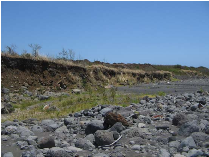
Photo n°10 – BERGE DE RIVE GAUCHE RECEMMENT ERODEE SUITE AU FORTES CRUES DE 2006 ET A LA CRUE DE 2007 EN AMONT DU STOCK
