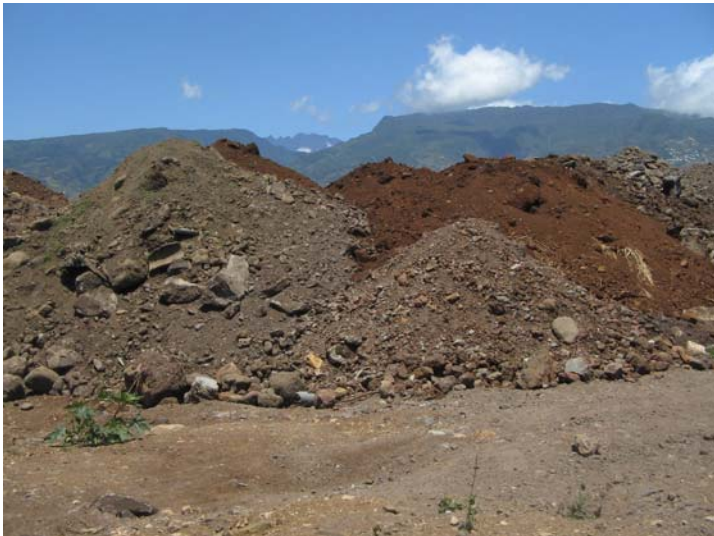
Photo n°12 – DEPOT EN TAS NON COMPACTES
