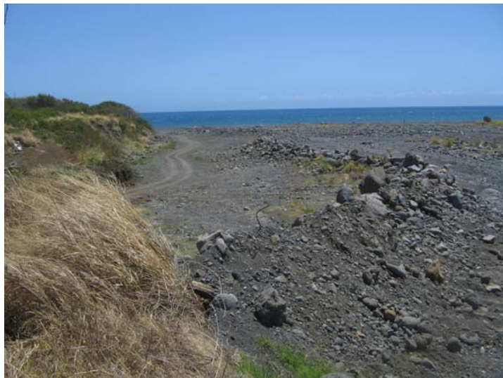
Photo n°9 – VUE DU MERLON DE PROTECTION EN TOUT- VENANT DANS LE LIT
