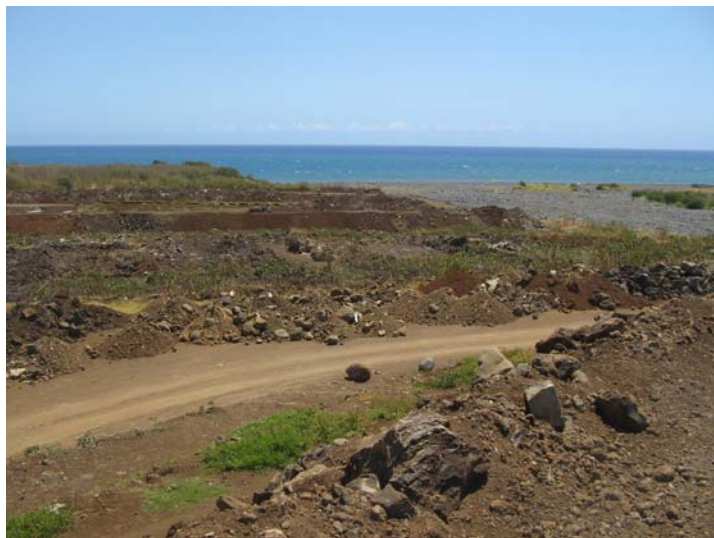
Photo n°3 – VUE DEPUIS L'AMONT DU STOCK DE DECHETS INERTES (PARTIE EST)
