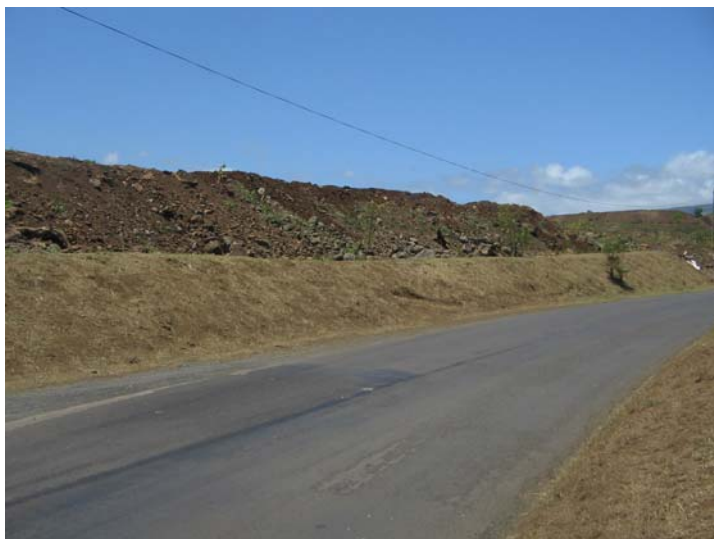
Photo n°4 – VUE DU STOCK COTE OUEST DEPUIS LA ROUTE LONGEANT LA RN2
