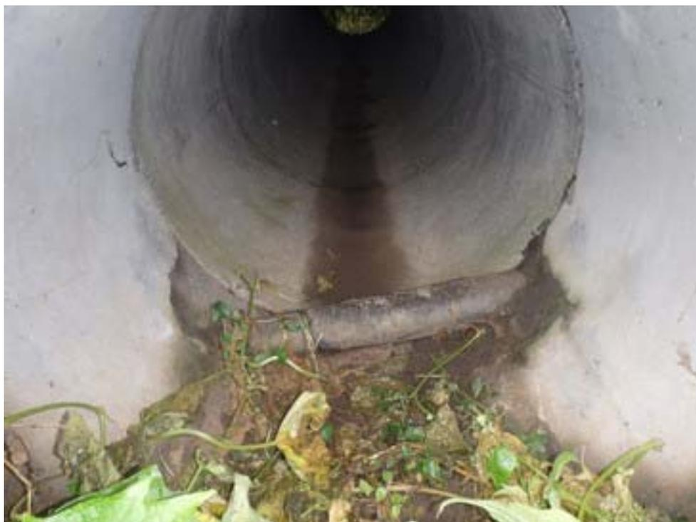
*Figure 24 : Radier n°8 – Présence de réseau en fil d'eau de buse*
