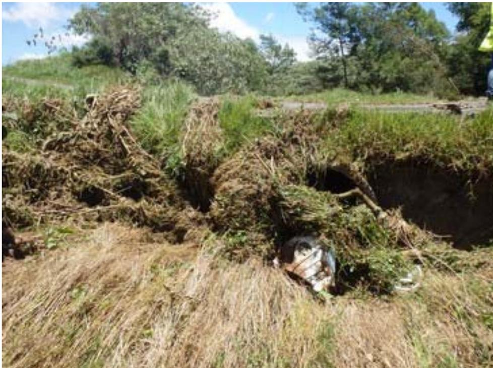
*Figure 13 : Radier n°58 – Encombrement de végétaux en amont des buses*
