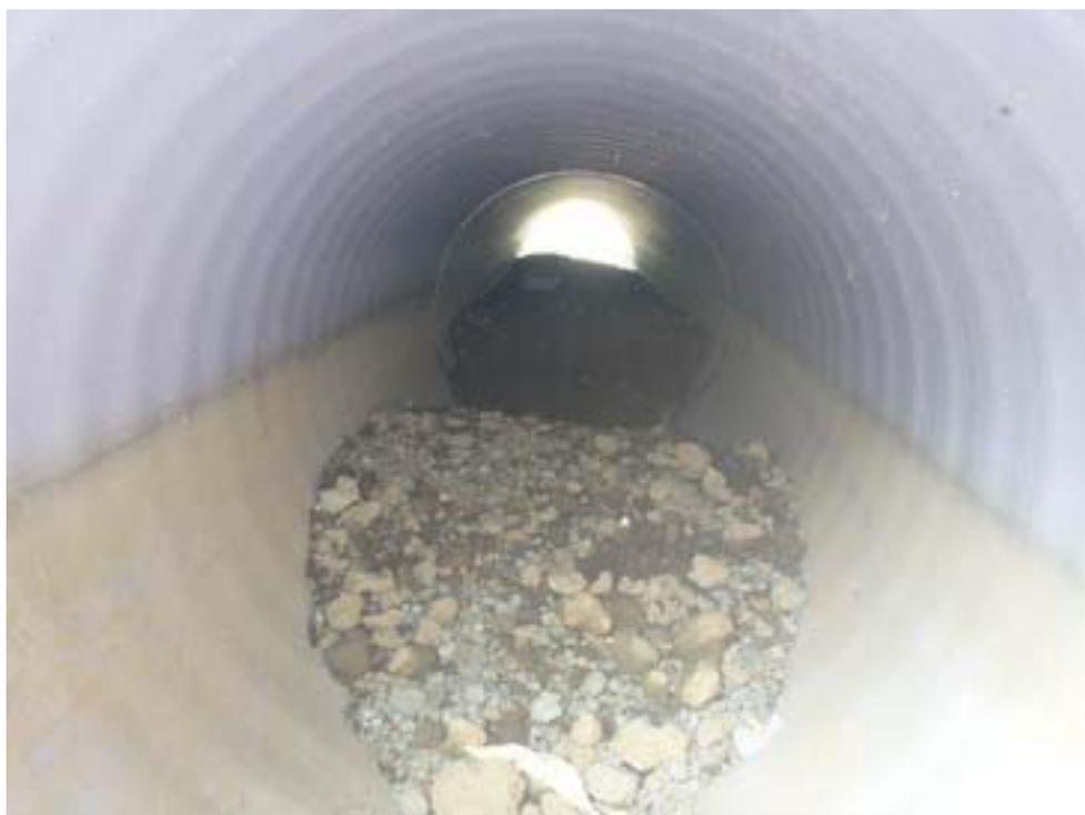
*Figure 15 : Radier n°89 – Présence de terre en fond de buse*
