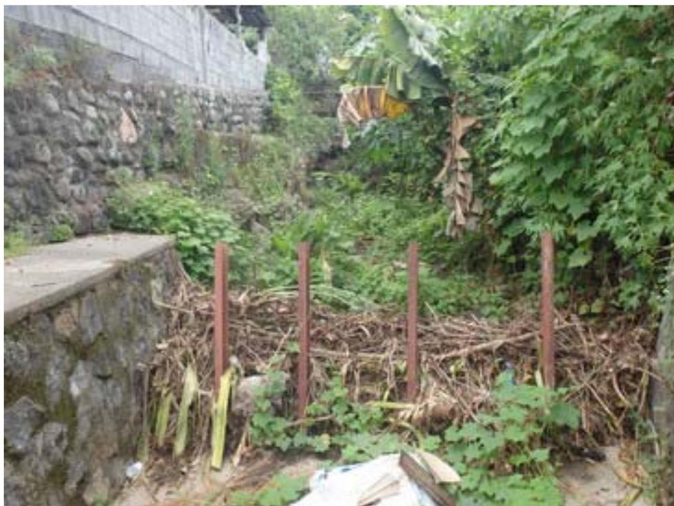
*Figure 14 : Radier n°98 – Encombrement de végétaux sur pièce à embâcles*
