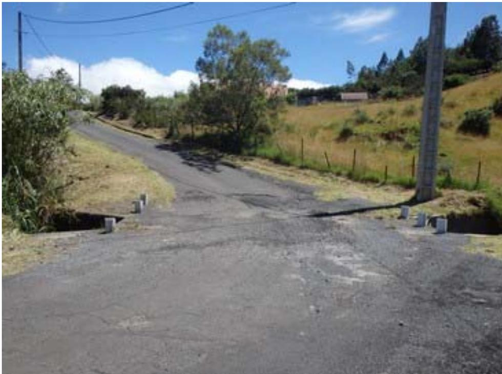
*Figure 17 : Défaut sur l'état de surface de la chaussée (exemple radier n°45)*
