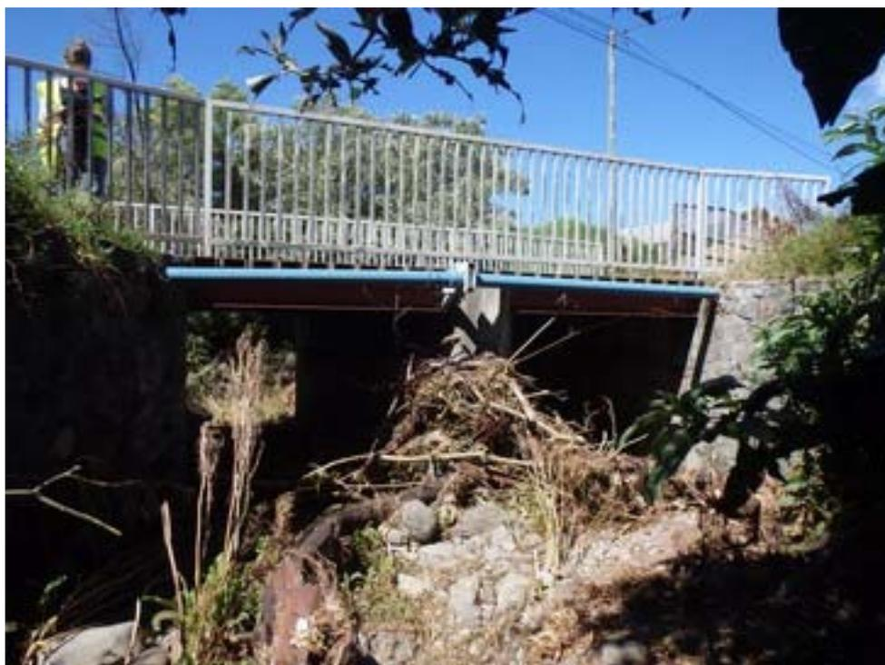
*Figure 11 : Radier n°41 – Encombrement de végétaux au niveau de la pile intermédiaire*
