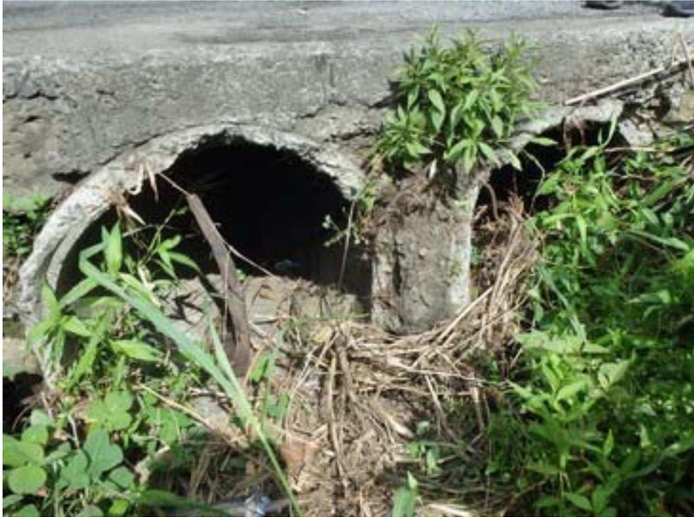
*Figure 18 : Têtes de buses abimées*
