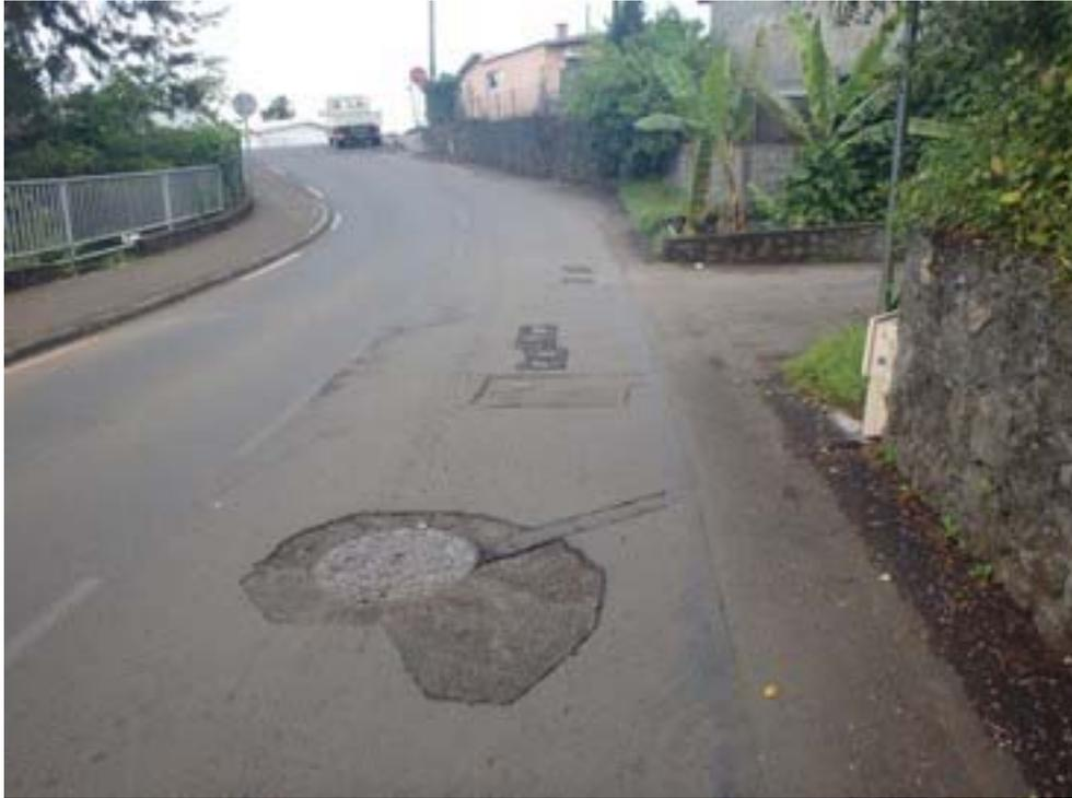
Figure 20 : Défaut structurel sur chaussée au niveau des regards et bouche à clefs
