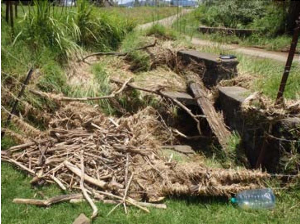
*Figure 12 : Radier n°61 – Entassement de végétaux en amont de l'ouvrage - Blocage effectué par la clôture de la parcelle*
