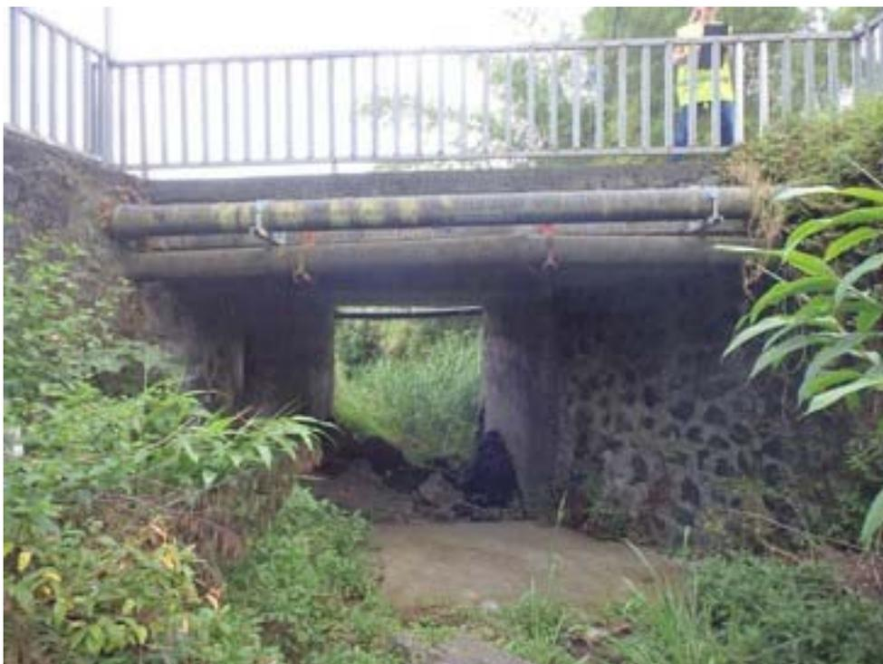
*Figure 22 : Radier n°97 – Réseaux Amont et Aval dans la section hydraulique*
