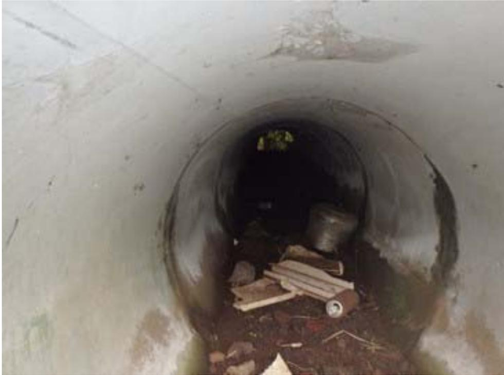
*Figure 16 : Radier n°90 – Présence de terre et autres déchets en fond de buse*
