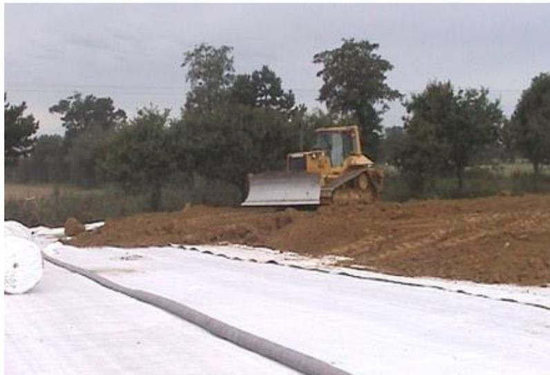
Figure 15 : Exemple de mise en œuvre d'un géocomposite de drainage
