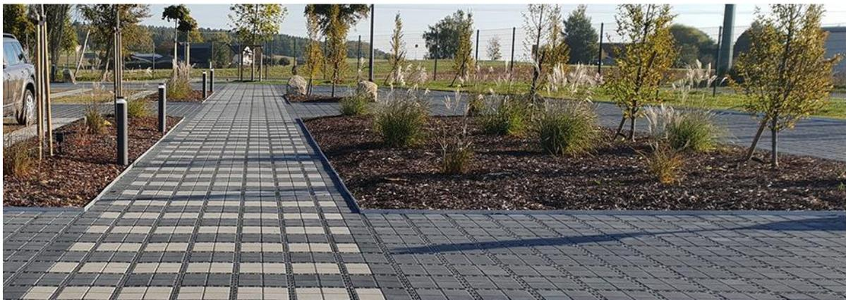
Figure 17 : Exemple de dalles perméables (source <https://www.ecovegetal.com>)
