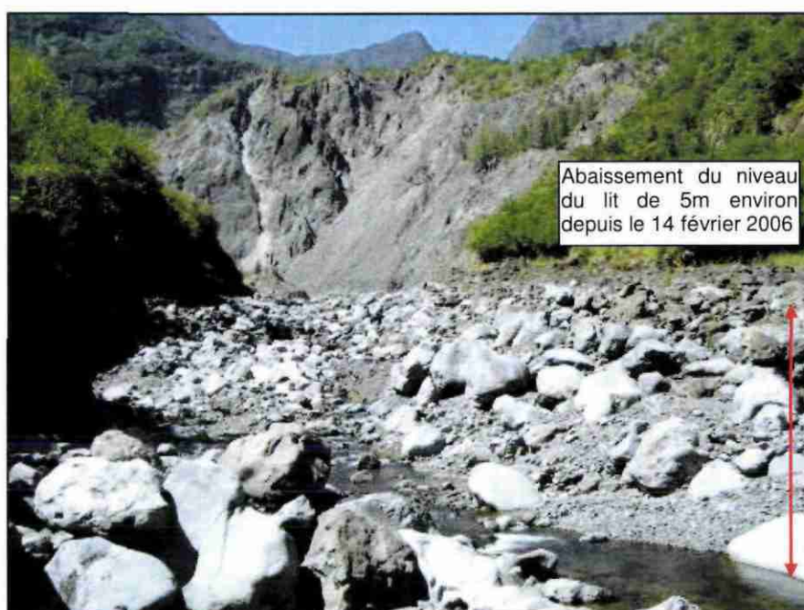
Illustration 42 : creusement du lit à l'aval immédiat du barrage en 2007 (cliché décembre 2007)
