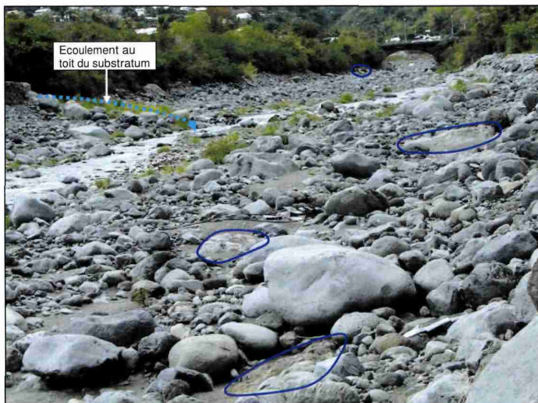
Illustration 10 : affleurements du substratum rocheux dans le lit mineur en aval du pont Domenjod
