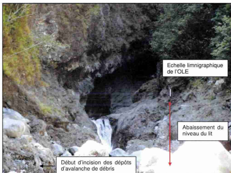
Illustration 46 : verrou situé en amont du chantier du transfert des eaux en décembre 2007.
