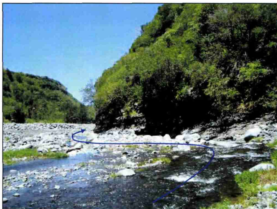
Illustration 9 : berge rocheuse située en face de l'Ilet Quinquina amont (formation d'un point dur et déviation de l'écoulement)
