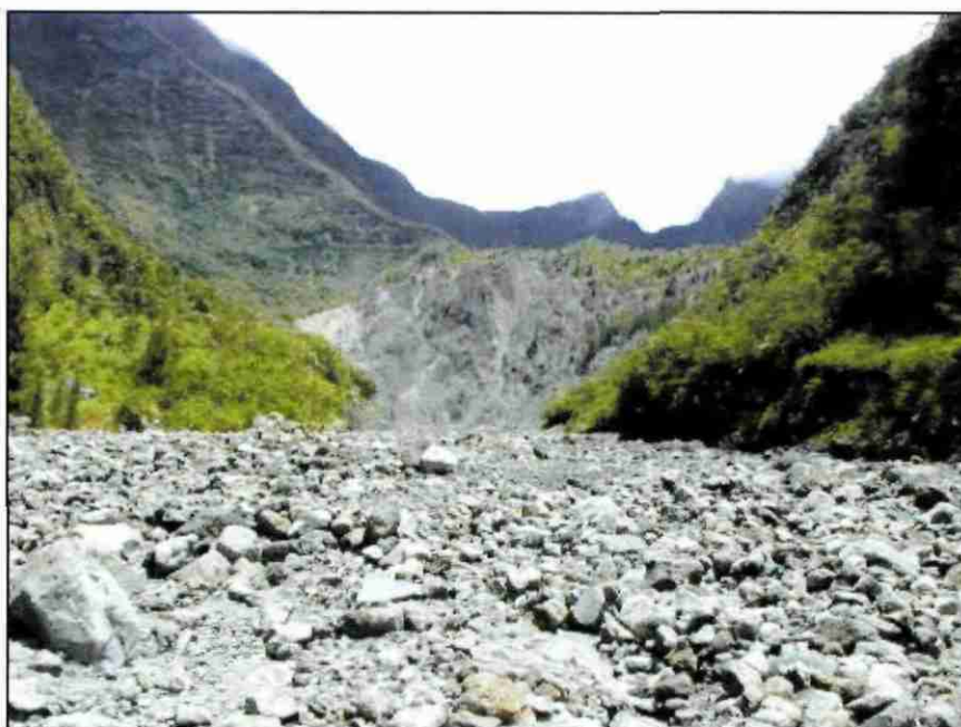
Illustration 40 : engravement du lit de la Rivière des Pluies à l'aval du barrage (cliché 2003)
