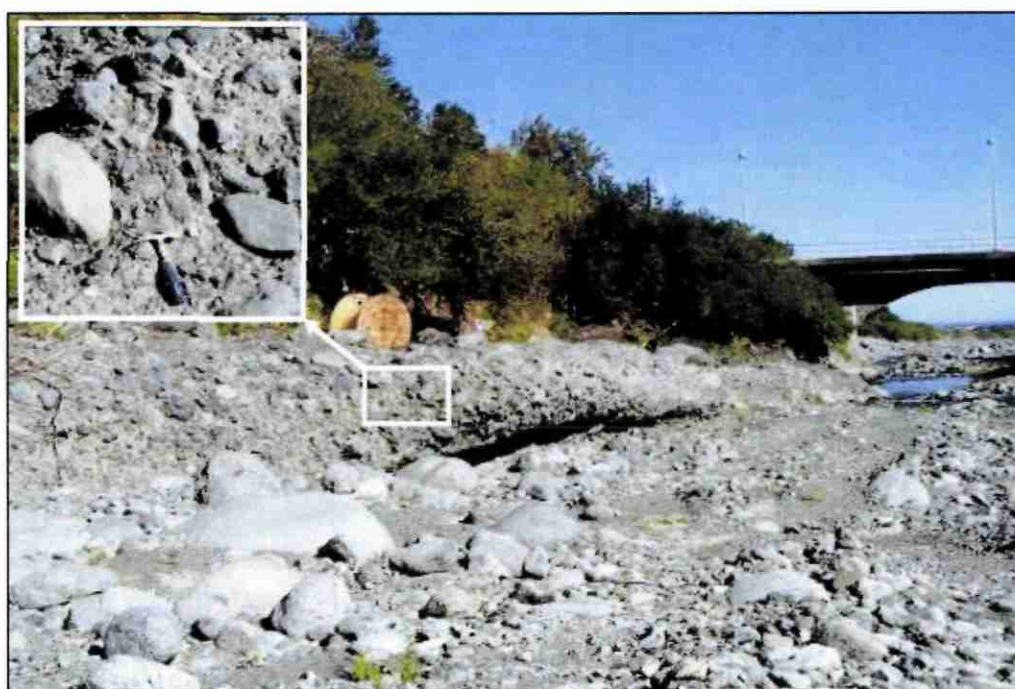
Illustration 16 : dépôts cimentés de coulées de débris au niveau du pont de Domenjod.
