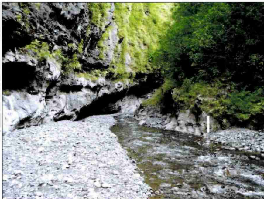
Illustration 45 : dépôts à la sortie du verrou situé en amont du chantier du transfert des eaux en décembre 2003.
