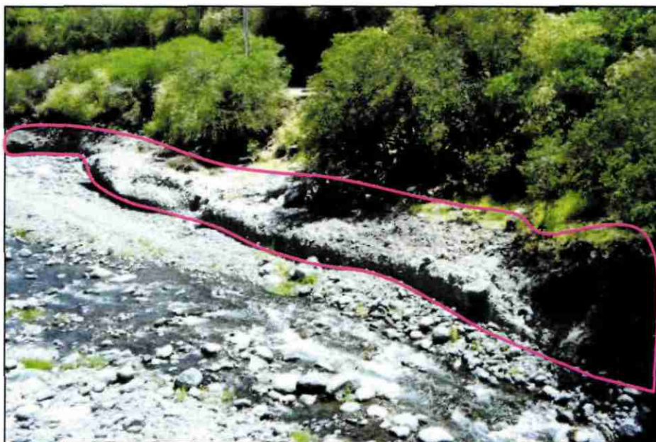
Illustration 20 : berges « résistantes » de coulées de débris cohésives au droit du Pont Domenjod
