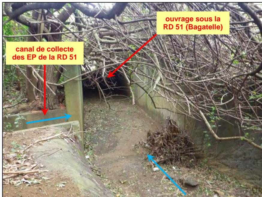
**Photo.-15. Franchissement du canal intercepteur par la RD 51**
