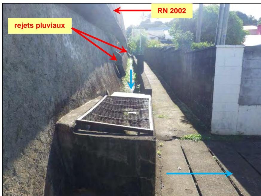
**Photo.-9.** Rejet pluvial issu de la RN 2002
