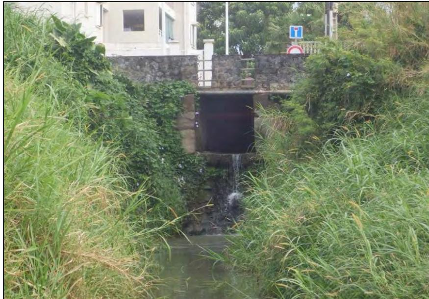
**Photo.-13. Chute en aval de l'ouvrage-cadre**
