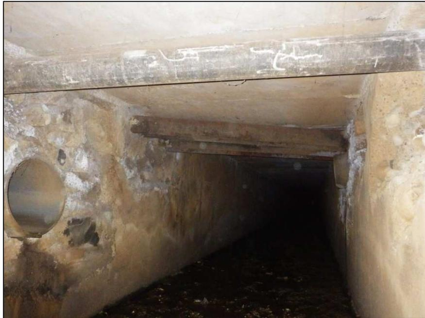
**Photo.-7. Canalisations EU en travers de l'ouvrage-cadre**
