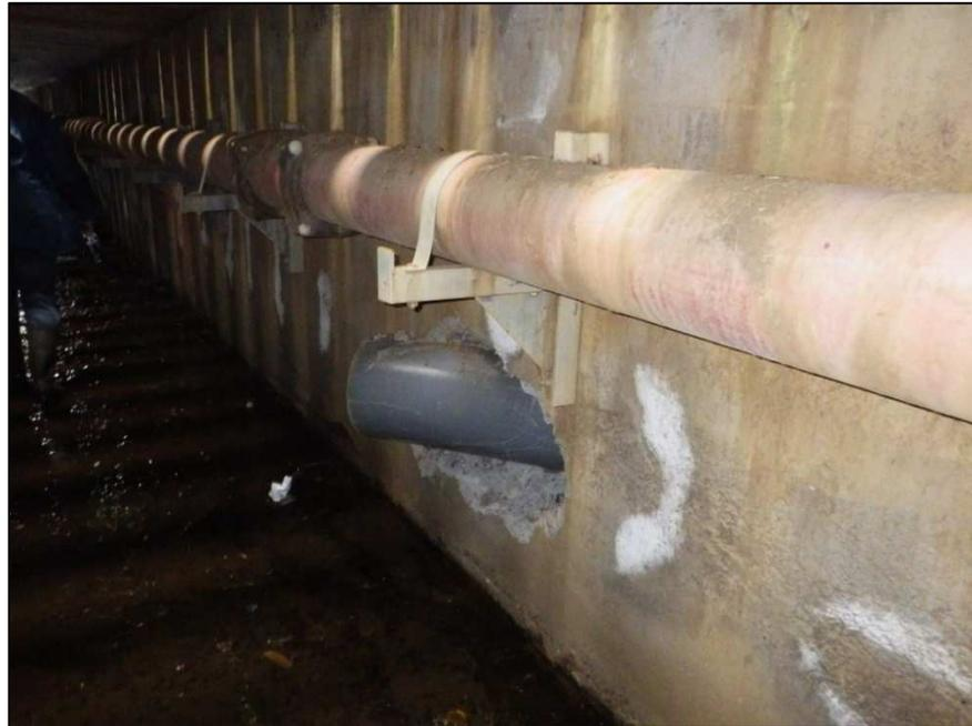
**Photo.-10. Rejet pluvial dans le tronçon aval de l'ouvrage-cadre**
