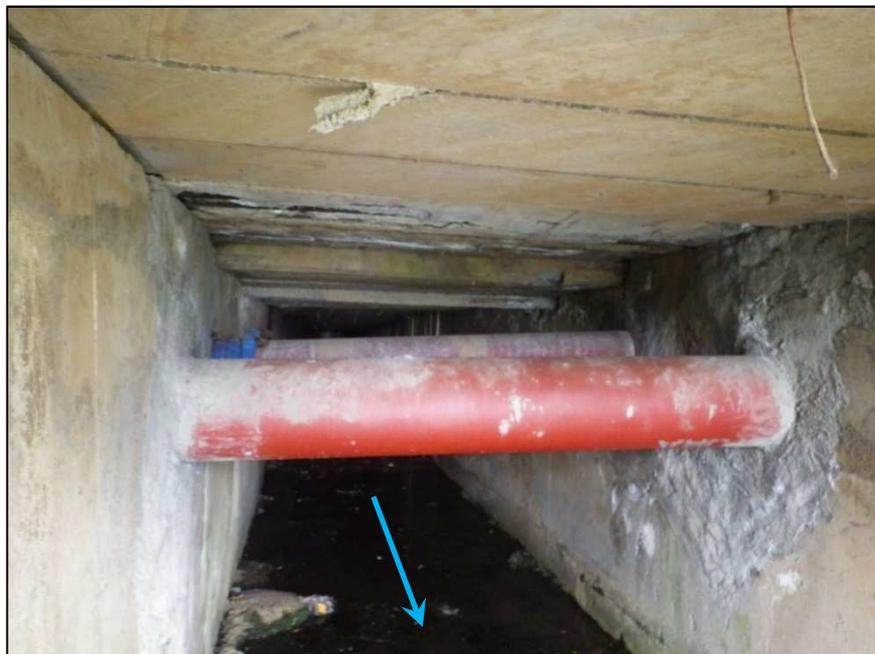
**Photo.-12. Canalisations en travers de l'ouvrage-cadre aval**
