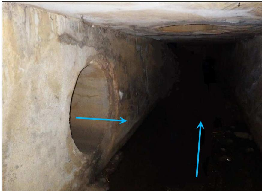
**Photo.-3.** Rejet pluvial à l'aide d'une buse Ø 1200 mm
