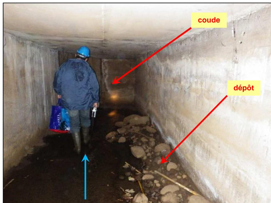
**Photo.-2.** Dépôts de matériaux dans l'ouvrage-cadre (amont RN 2002)
