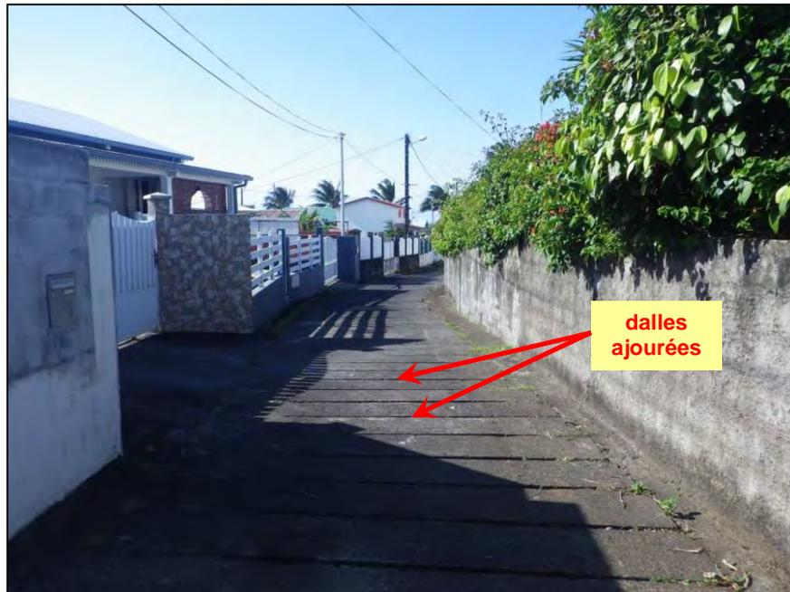
**Photo.-8.** Couverture ajourée de l'ouvrage-cadre situé en aval de la RN 2002
