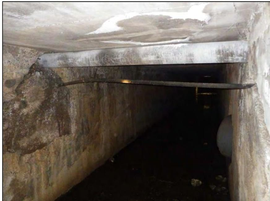
**Photo.-6. Canalisations EU et AEP en travers de l'ouvrage-cadre**
