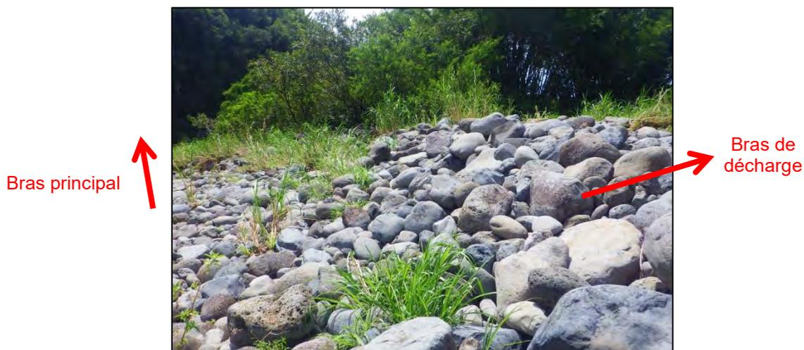
Fig. 5. Merlon de surverse vers le bras de décharge (photo 2017)
