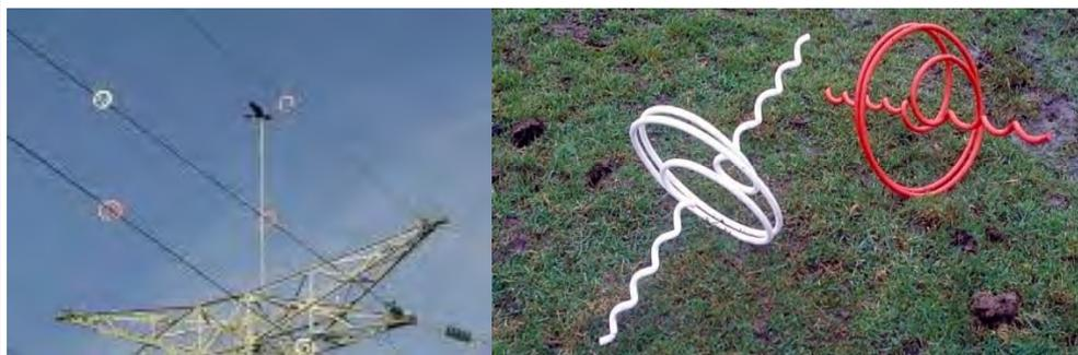
Figure 62 : Spirale de signalement de lignes/câbles
