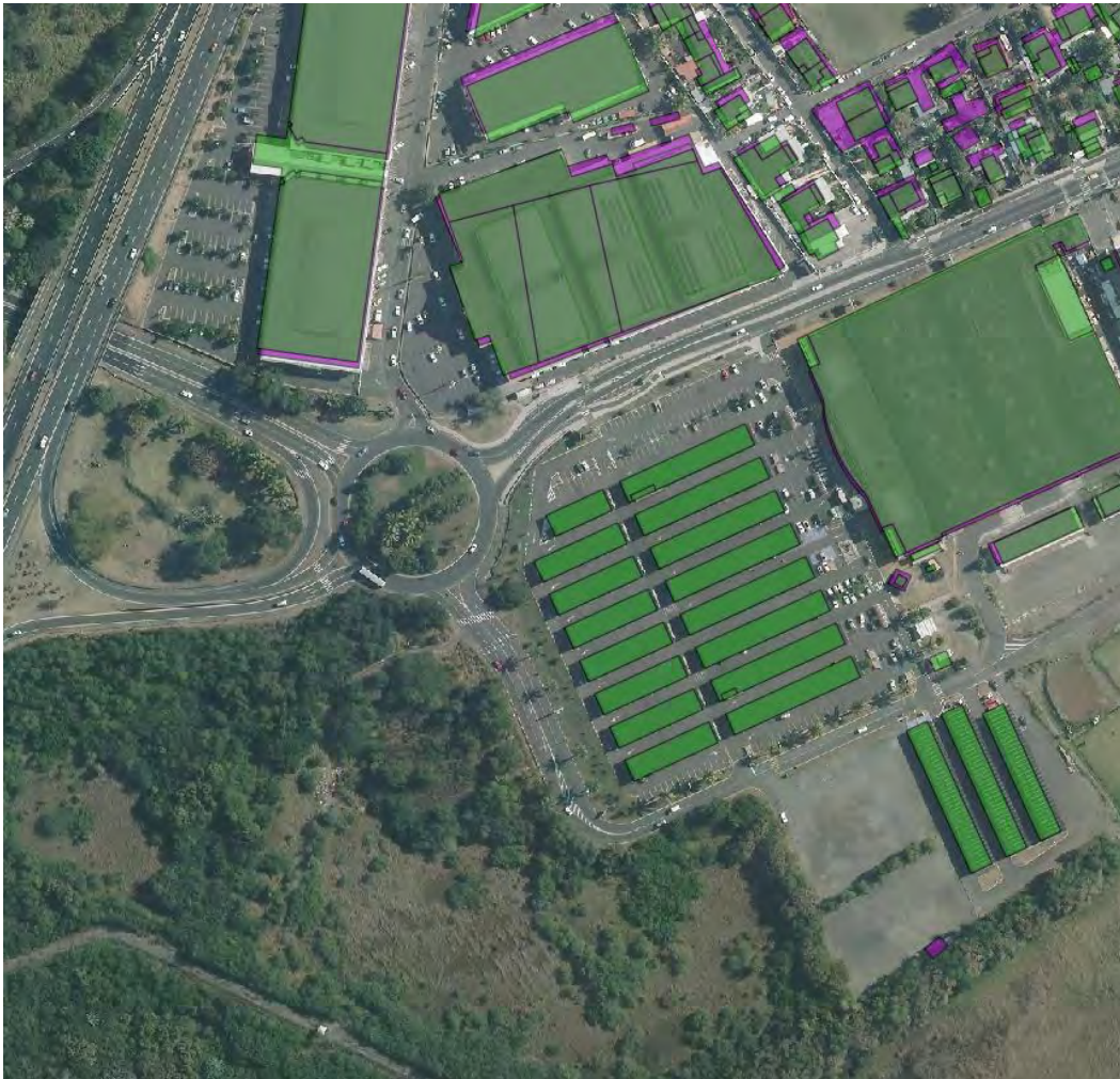
Figure 16 : Panneaux solaires sur le parking du centre commercial de Savanna, source : Direction Générale des finances publiques.
