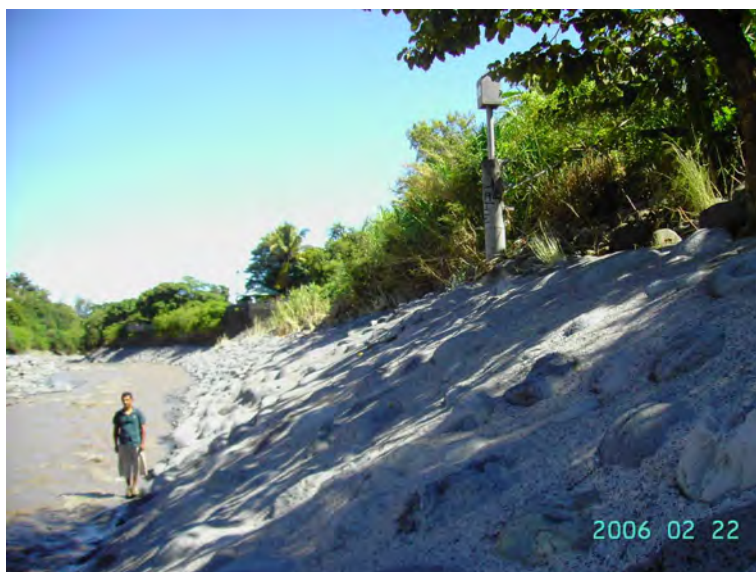
Photo n°41 – STATION 21101 APRES LA CRUE DE FEVRIER 2006 (OLE)
