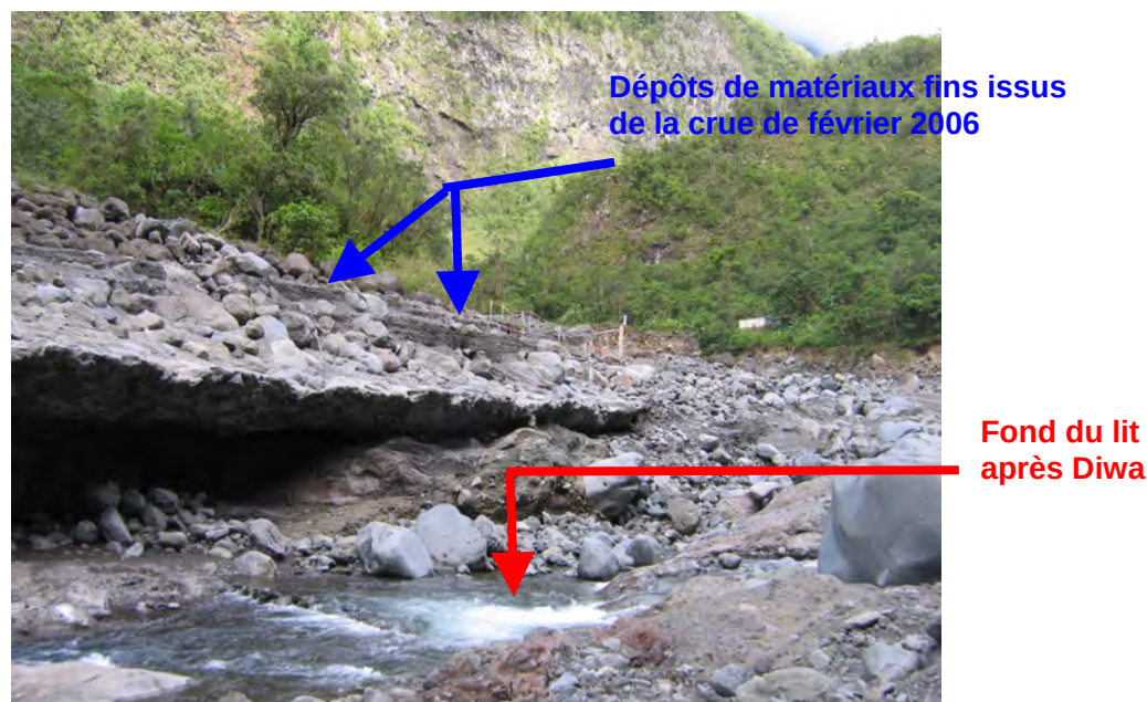
Photo n°69 – DIWA – ABAISSEMENT DU LIT AU NIVEAU DE LA PLATEFORME, DECHAUSSEMENT DE LA PROTECTION EN ENROCHEMENTS LIES ET AFFLEUREMENT DE MATERIAUX CIMENTES (11 AVRIL 2006)
