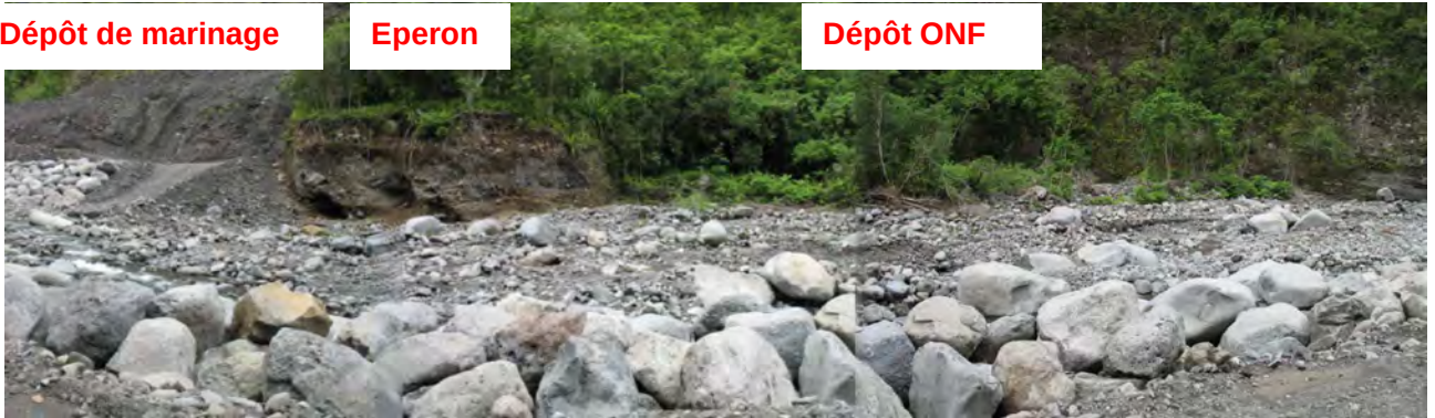
Photo n°64 – VUE DU DEPOT DE MARINAGE ACTUEL ET DE L'EXTENSION « ONF » (12/01/07)
