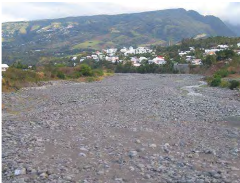
Photo n°21 – VUE DEPUIS LE PONT METALLIQUE DE LA RN102
