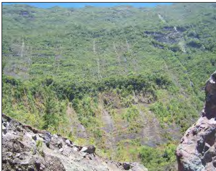
Photo n°50 – ARRACHEMENTS DANS LE REMPART EST DOMINANT LE GRAND EBOULIS
