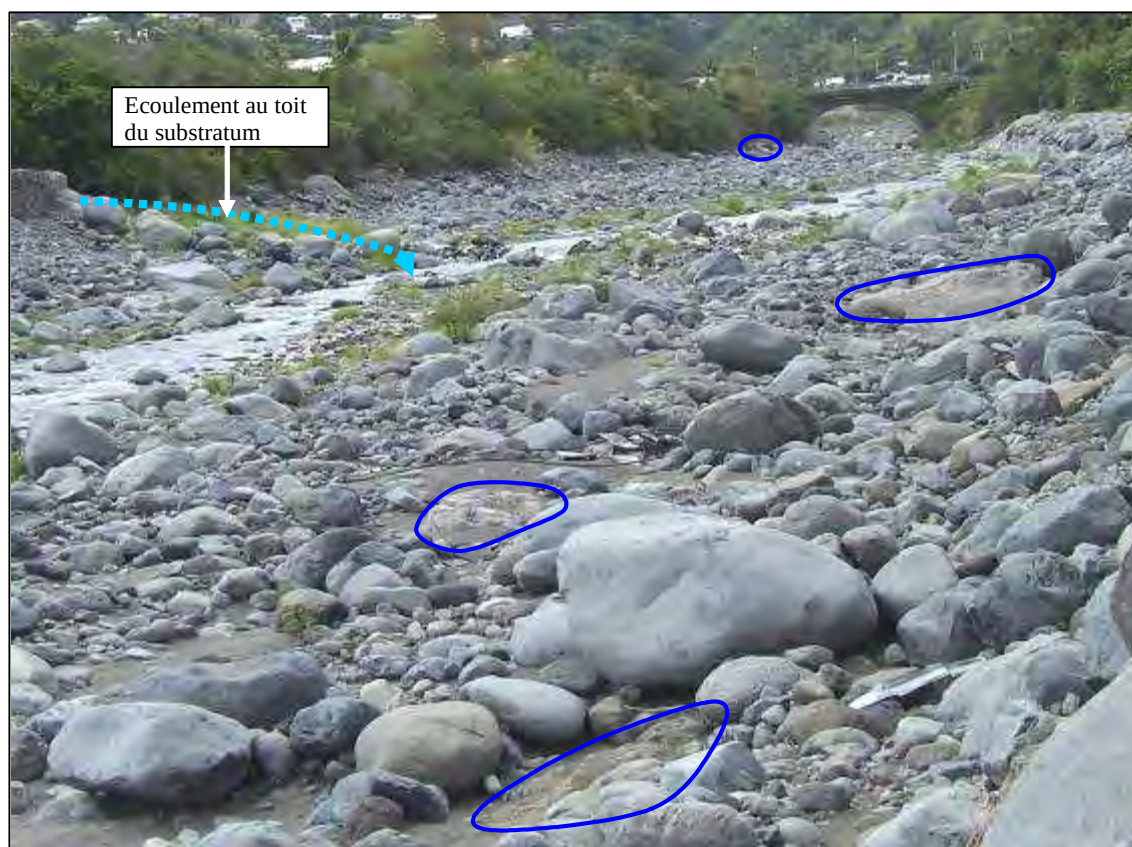
Photo n°3 – AFFLEUREMENTS DU SUBSTRATUM ROCHEUX DANS LE LIT MINEUR EN AVAL DU PONT DOMENJOD
