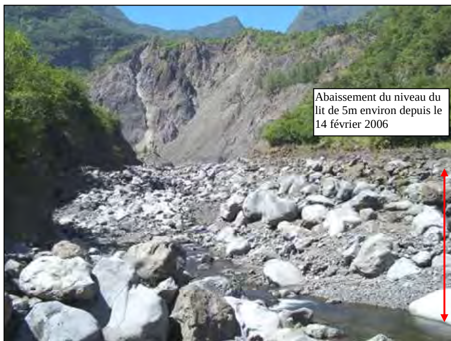
Photo n°77 – CREUSEMENT DU LIT A L'AVAL IMMEDIAT DU BARRAGE EN 2007 (CLICHE DECEMBRE 2007)
