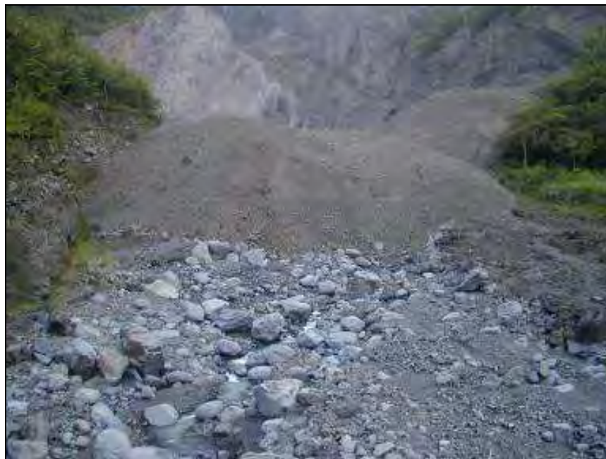
Photo n°60 – FRONT DU BARRAGE EN 2002
