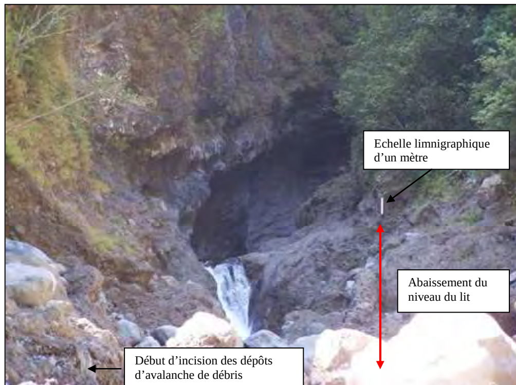
Photo n°81 – VERROU SITUE EN AMONT DU CHANTIER DU TRANSFERT DES EAUX EN DECEMBRE 2007
