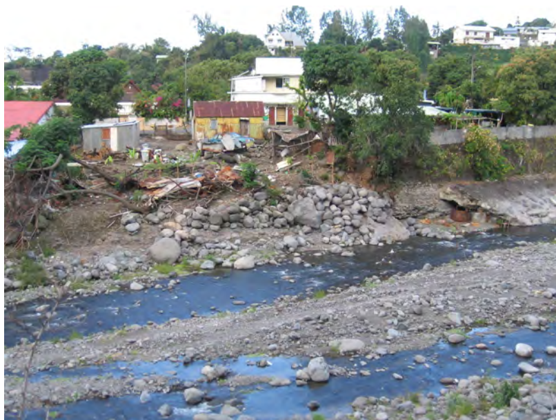
Photo n°33 – ARRIERE COUR DANS LE QUARTIER DE RIVIERE DES PLUIES
