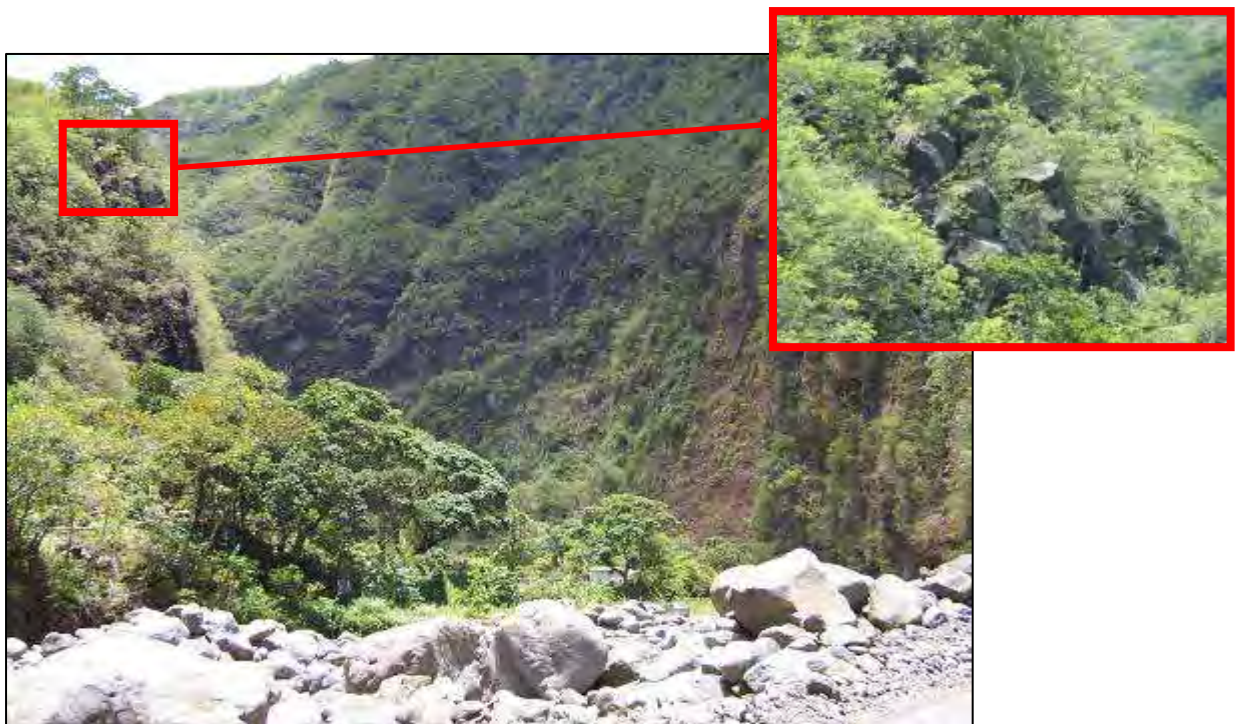
Photo n°52 – INSTABILITES DE VERSANT AU DROIT DE L'ÎLET LA PLUIE
