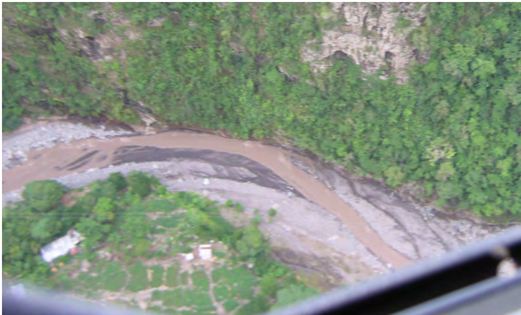
Photo n°70 – L'ILET LA PLUIE – DEPOT DE SEDIMENTS FINS APRES LA CRUE DE FEVRIER 2006 (25 FEVRIER 2006)
