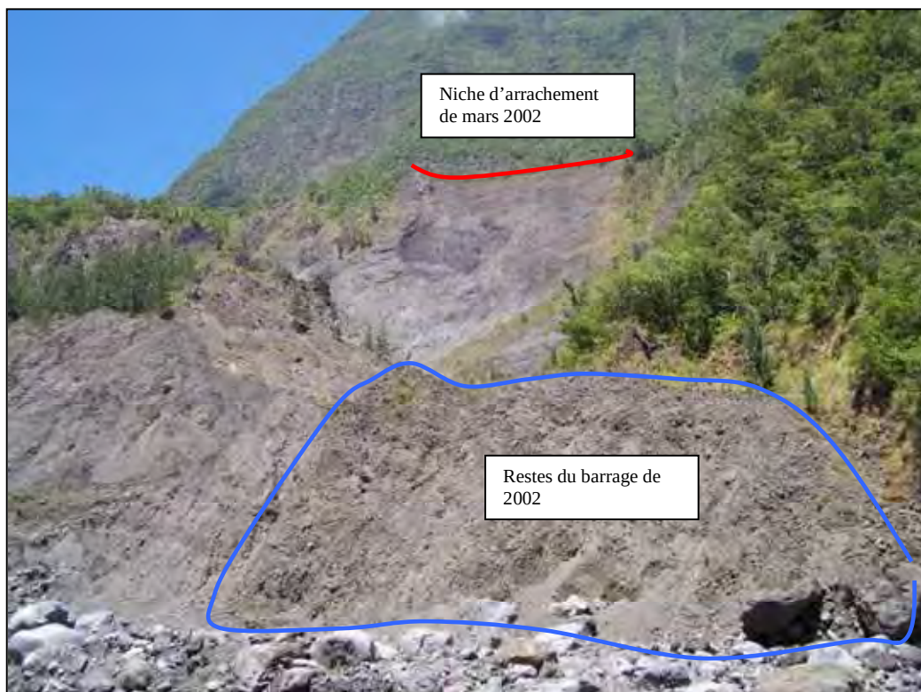
Photo n°82 – VUE D'ENSEMBLE DE L'ÉBOULEMENT DE MARS 2002 (CLICHE DECEMBRE 2007)
