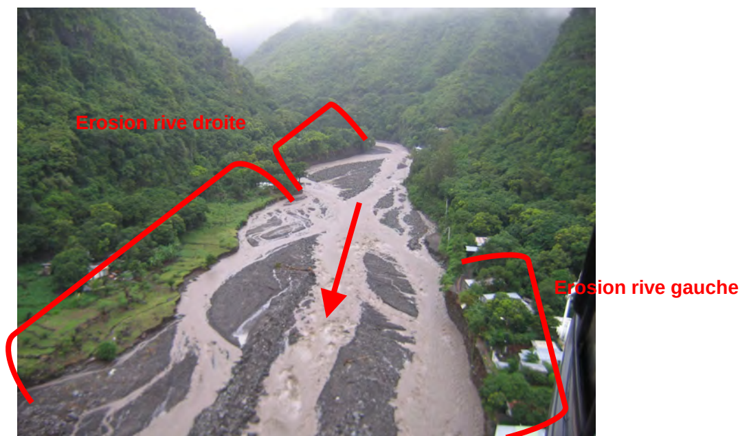
Photo n°73 – PARTIE AMONT DE L'ILET QUINQUINA – VUE VERS L'AMONT APRES DIWA (7 MARS 2006)
