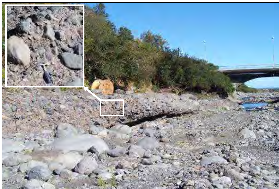
Photo n°9 – DEPOTS CIMENTES DE COULEES DE DEBRIS AU NIVEAU DU PONT DE DOMENJOD
