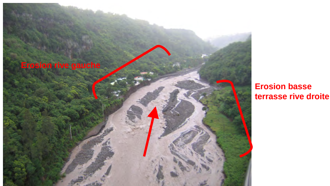
Photo n°74 – PARTIE AMONT DE L'ILET QUINQUINA – VUE VERS L'AVAL APRES DIWA (7 MARS 2006)
