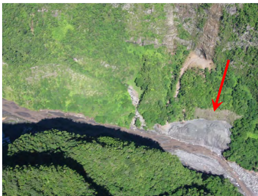
Photo n°63 – CRUE DE FEVRIER 2006 – DESTRUCTION DE LA PROTECTION DU DEPOT DE MARINAGE ET DEPART DE MATERIAUX (22 FEVRIER 2006)
