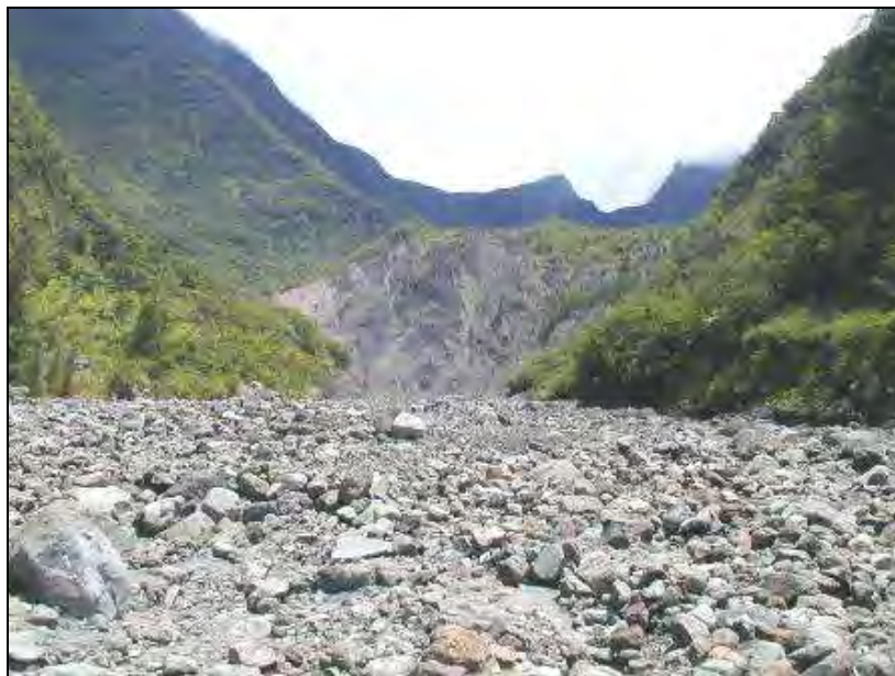
Photo n°75 – ENGRAVEMENT DU LIT DE LA RIVIERE DES PLUIES A L'AVANT DU BARRAGE (CLICHE 2003)
