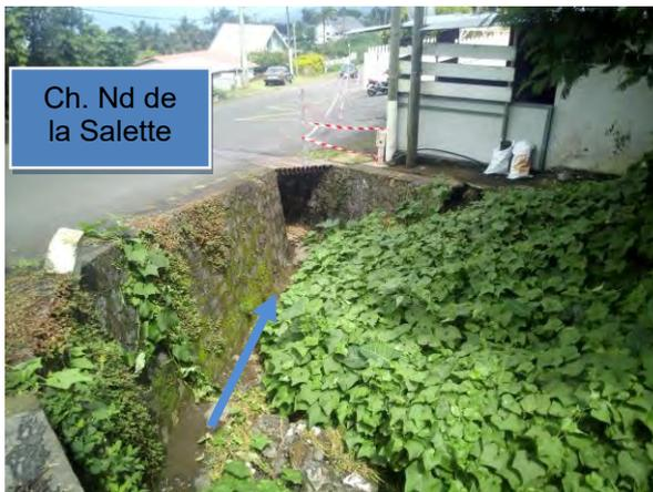
**Photo 7.** Entonnement dans le canal traversant le Ch. notre Dame de la Salette
