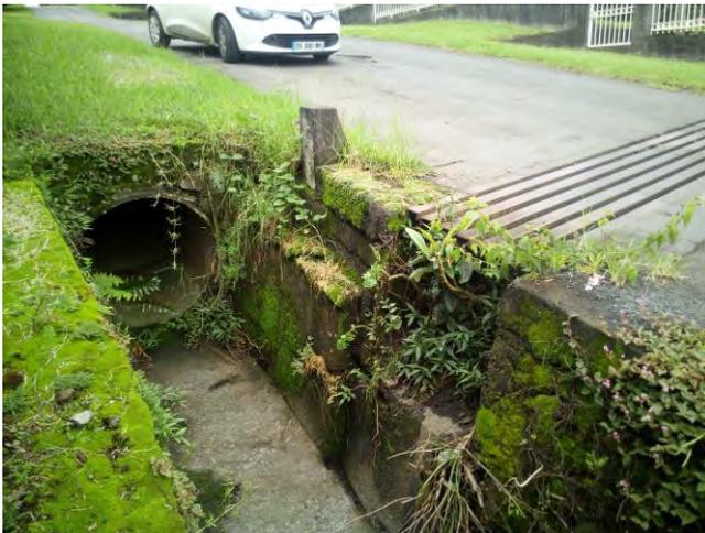
**Photo 10. Sortie de la canalisation béton
