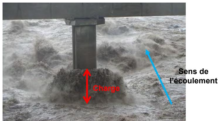
Fig. 3. Représentation de la charge sur une pile de pont
