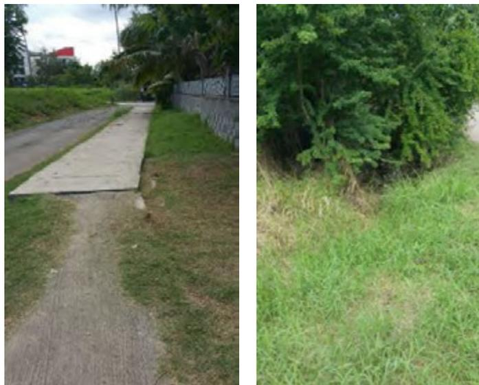
Figure 63 : Système d'évacuation à nettoyer – Partie amont enterrée à gauche et partie aval ouverte à droite
