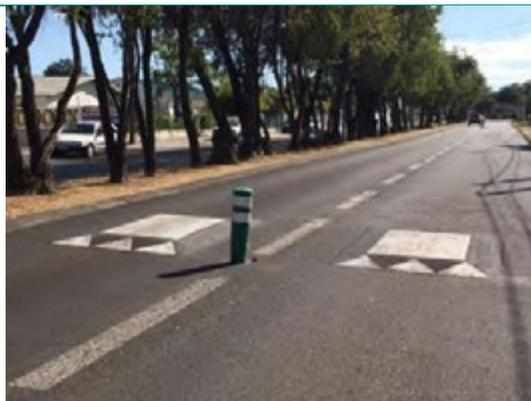
Figure 75 : Exemple de dos d'âne permettant les écoulements sur l'avenue du stade - MRP2.
