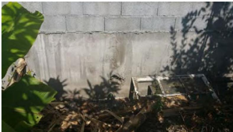
Figure 73 : Trou dans le mur
