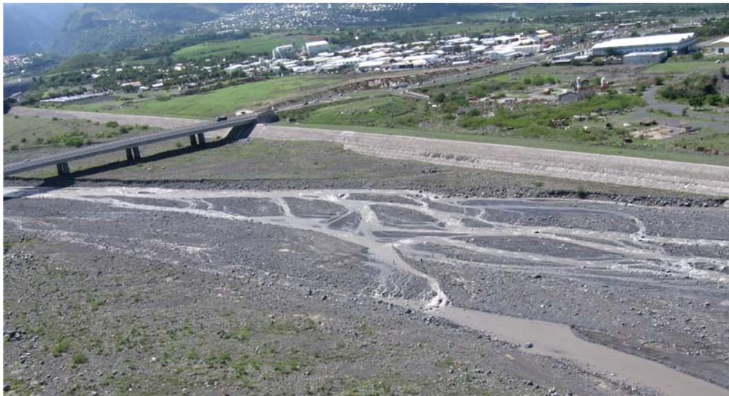
*Photo n°1 – EXEMPLE DE PROTECTION LONGITUDINALE
