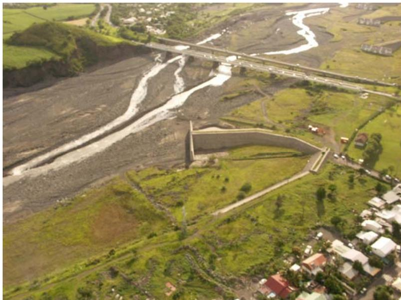
*Photo n°3 – EPI MARTEAU EN RIVE DROITE DE LA RIVIERE DES GALETS*
