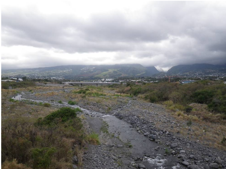
Fig. 24. VUE DU PONT DU BOULEVARD SUD
