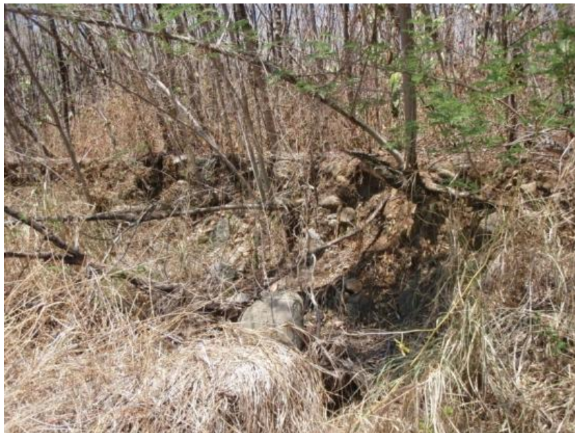
Fig. 15. EROSION DE LA BERGE DE LA TERRASSE RECENTE EN RIVE DROITE
