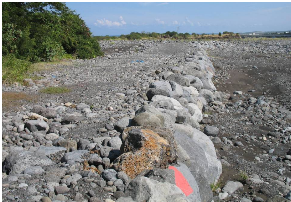
Fig. 61. EXEMPLE DE RECTIFICATION DE BRAS VIF SUR LA RIVIERE SAINT ETIENNE
