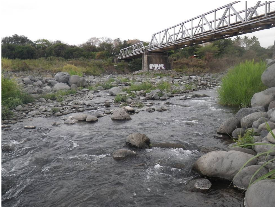
Fig. 23. VUE DU PONT METALLIQUE DE LA RN 102
