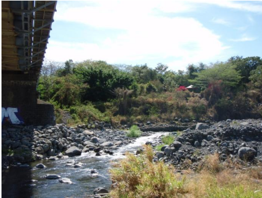
Fig. 11. INCISION DU LIT AU DROIT DU PONT DE LA RN 102
