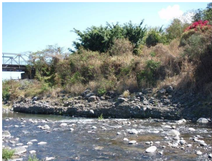
Fig. 8. ALLUVIONS ANCIENNES CIMENTEES EN RIVE DROITE, EN AMONT DU PONT DE LA RN 102
