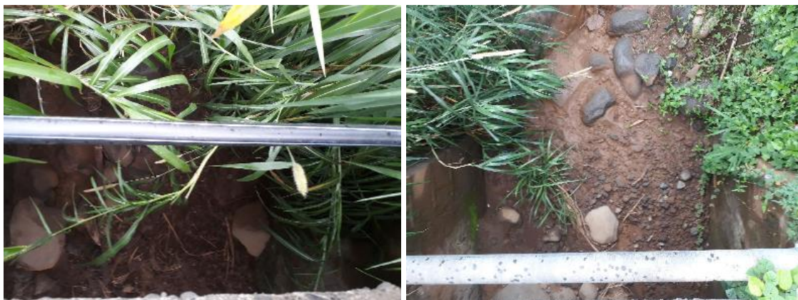
Figure 44 : Ouvrage à l'aval (à gauche) et à l'amont (à droite)
