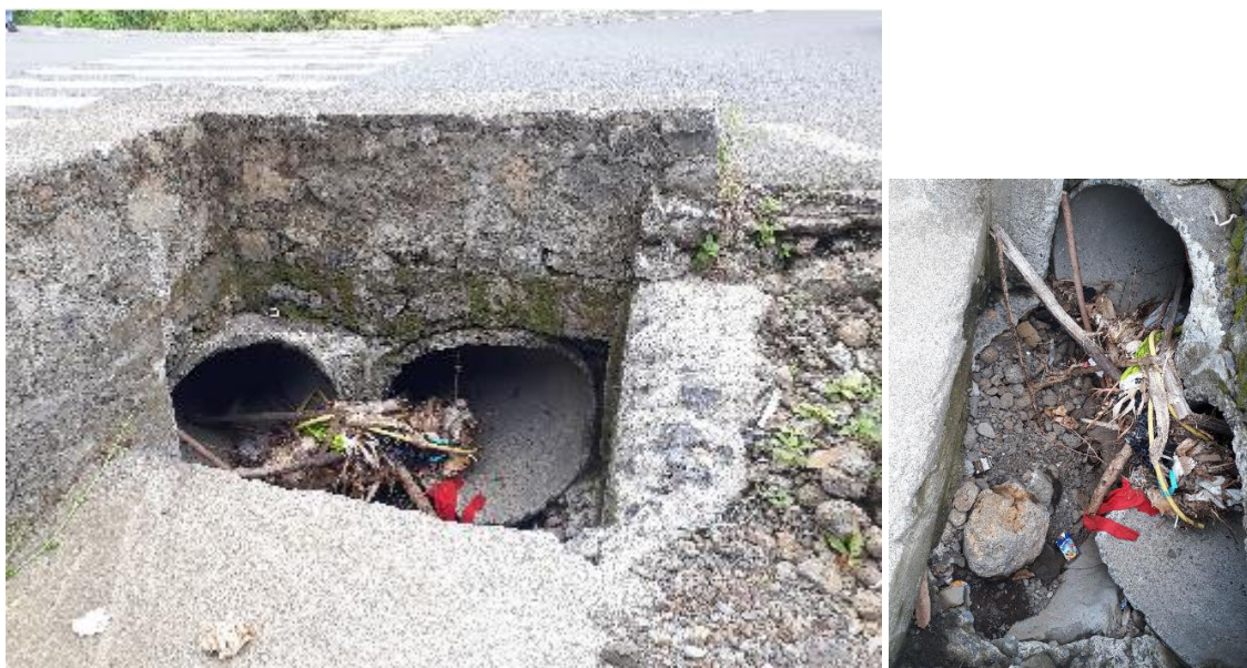
Figure 9 : Vue des 2 DN800 en contre bas de la dalle de protection d'un réseau
