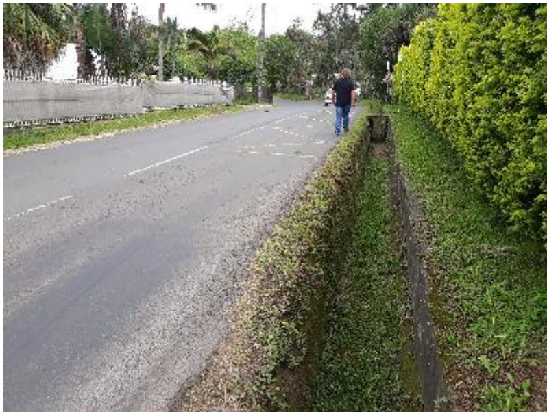
Figure 22 : fossé pluvial de la RD3 (vue vers le Nord)
