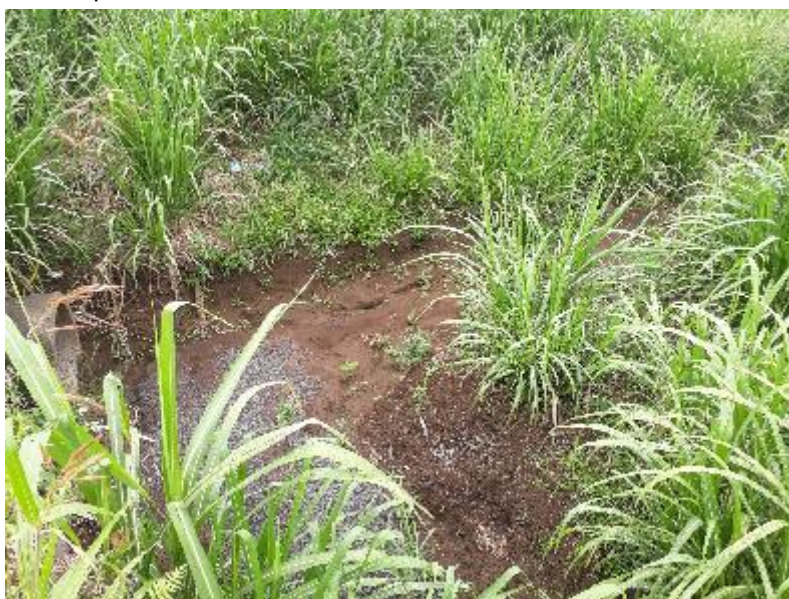
Figure 38 : Vue en aval de la voirie Ch Léopold Brabant
