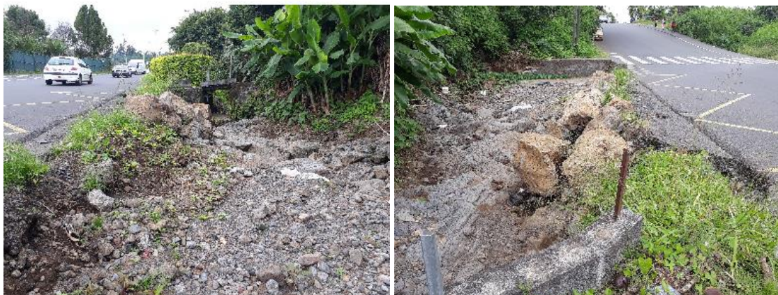
Figure 10 : Vues vers l'amont et l'aval de la rue Montaigne et du passage à gué
