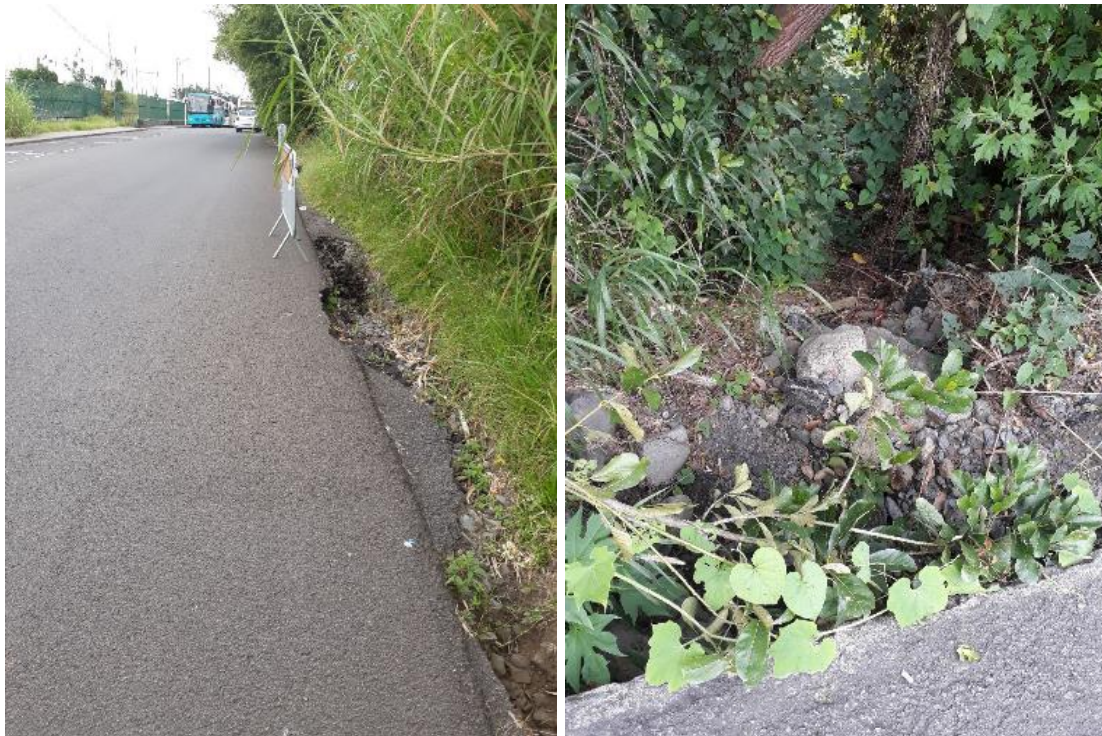
Figure 11 : Ravinement et retour à la ravine du ruissellement sur la Rue Montaigne
