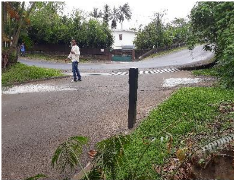
Figure 21 : traversée de la RD3 par la ravine affluent Trois Mares et réseau pluvial de la RD3
