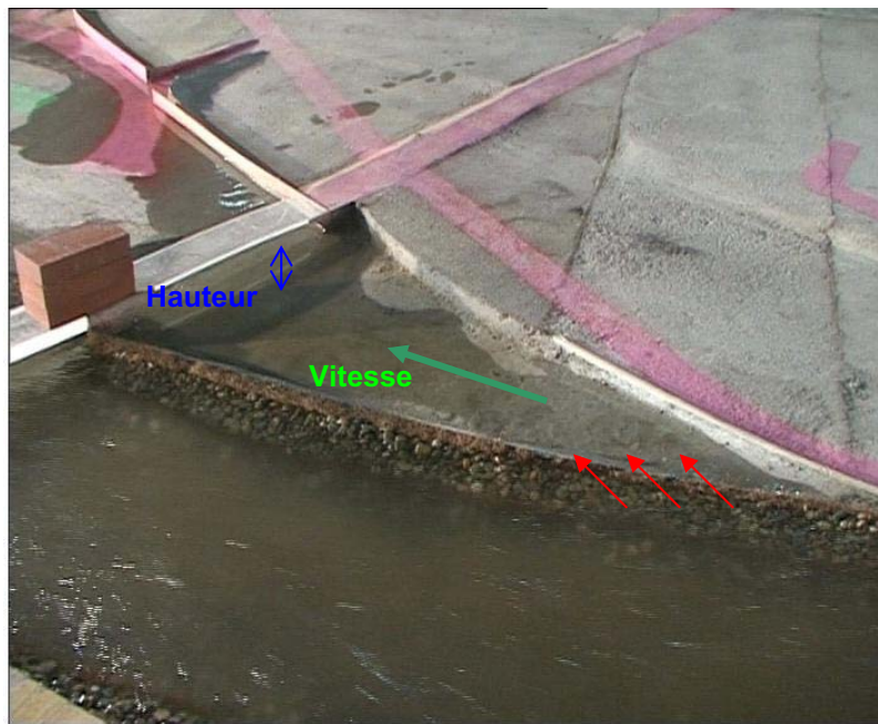
Début de débordement sur le déversoir latéral
