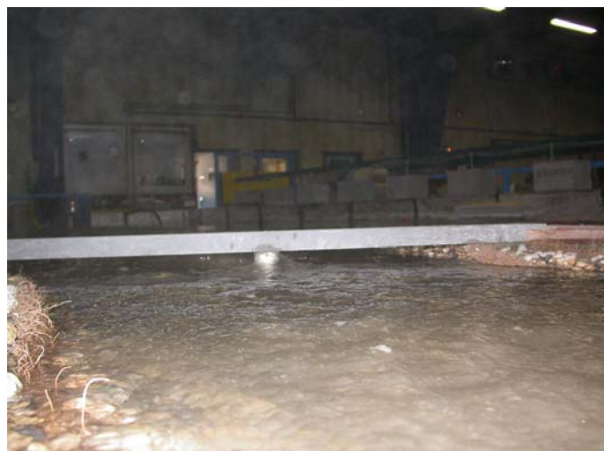
Écoulement sous le pont du centre ville
