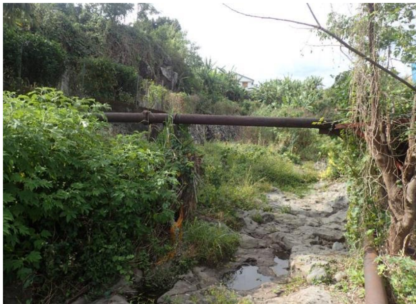
Figure 11 : conduite traversante (amont de l'ouvrage)
