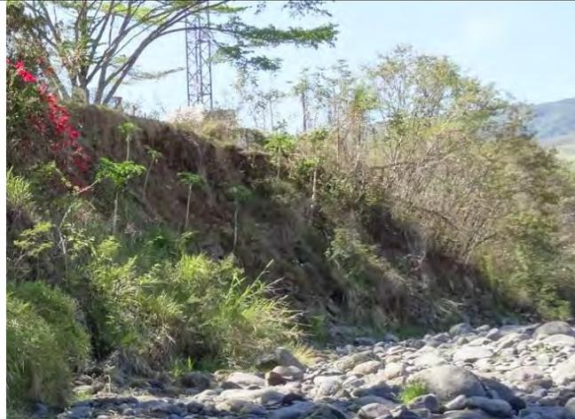
Photo 3 : Talus alluvionnaire pente ~1/1 environ 100 mètres en amont du pont
