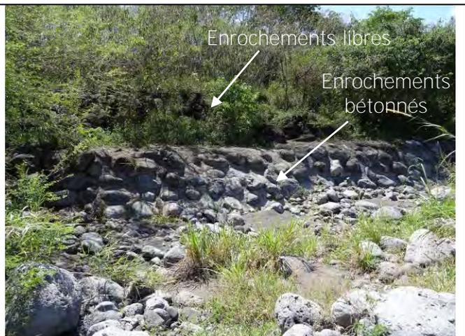
Photo 8 : enrochements bétonnés le long de la terrasse inférieure
