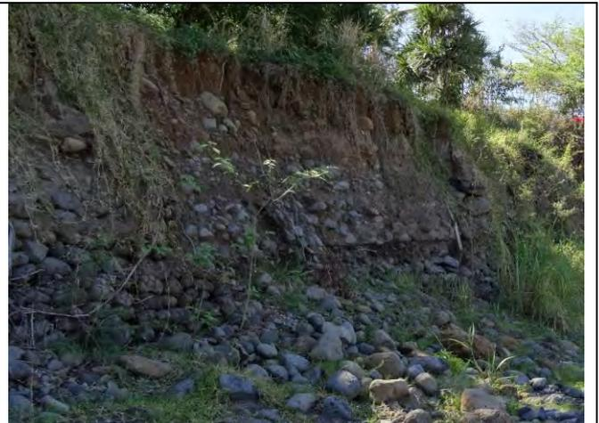
*Photo 2 : Talus alluvionnaire subvertical en amont immédiat du pont (gabions en pied de talus)*
