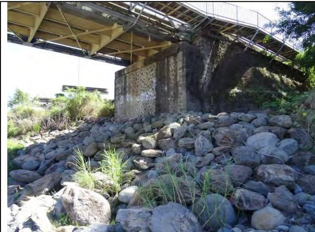
*Photo 1 : Enrochements libres protégeant la culée droite du pont de la RN102*
