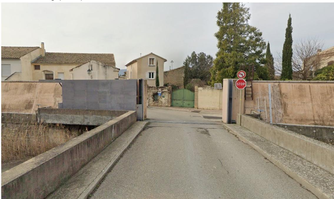
Figure 37 : Exemple de porte batardable à fermeture manuelle - Codolet
