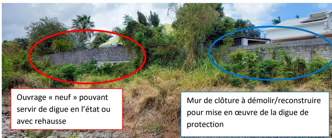
Figure 36 : Murs moellons « neuf » de clôture riverain en amont direct du radier existant – Bras principal
