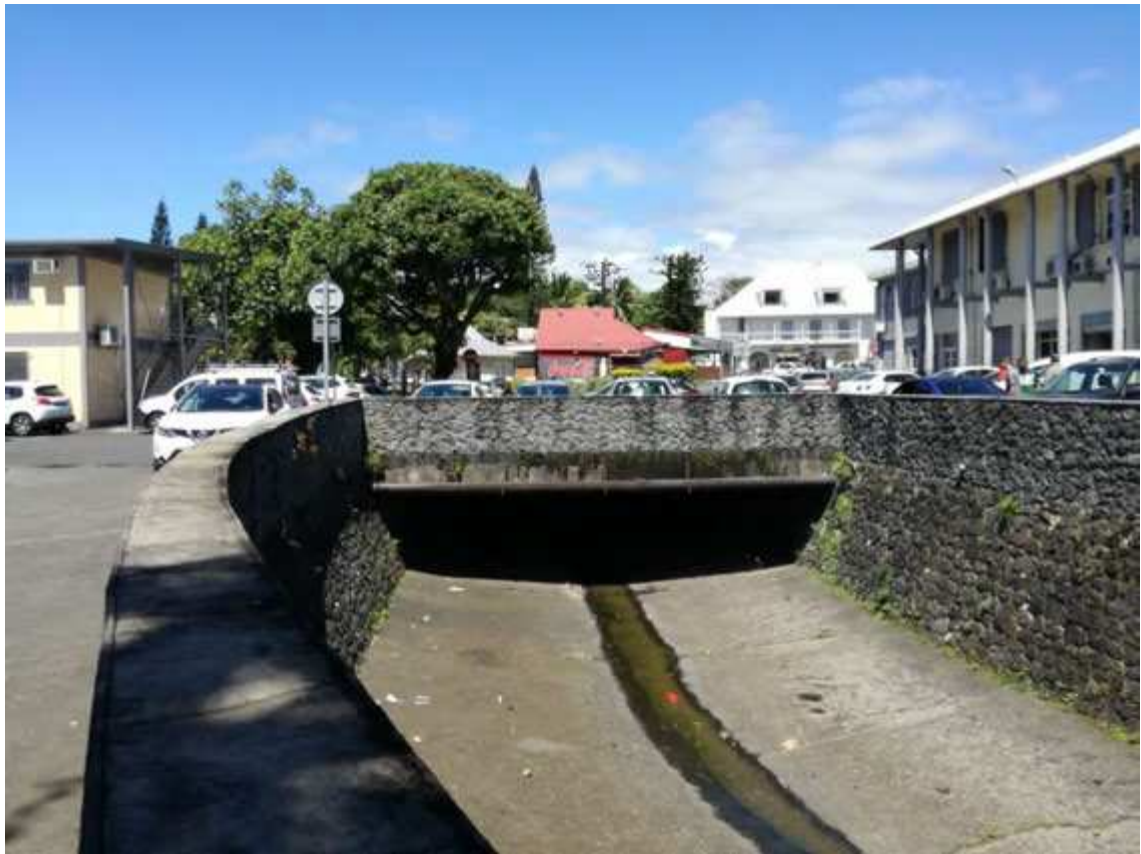
Photo.-5. Pont de la République – vue aval
