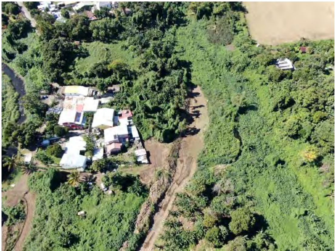
Photo.-1. Vues aériennes du site post-travaux DEAL (source CIREST)
