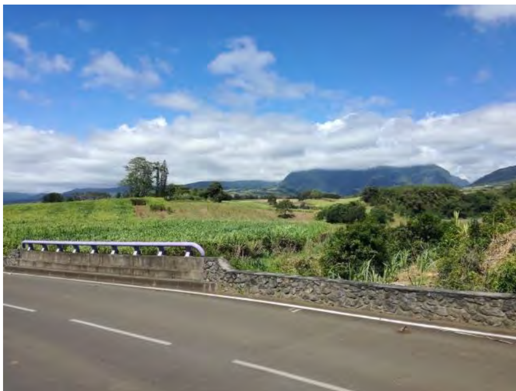
Fig. 31. Vue amont Chemin Morin
