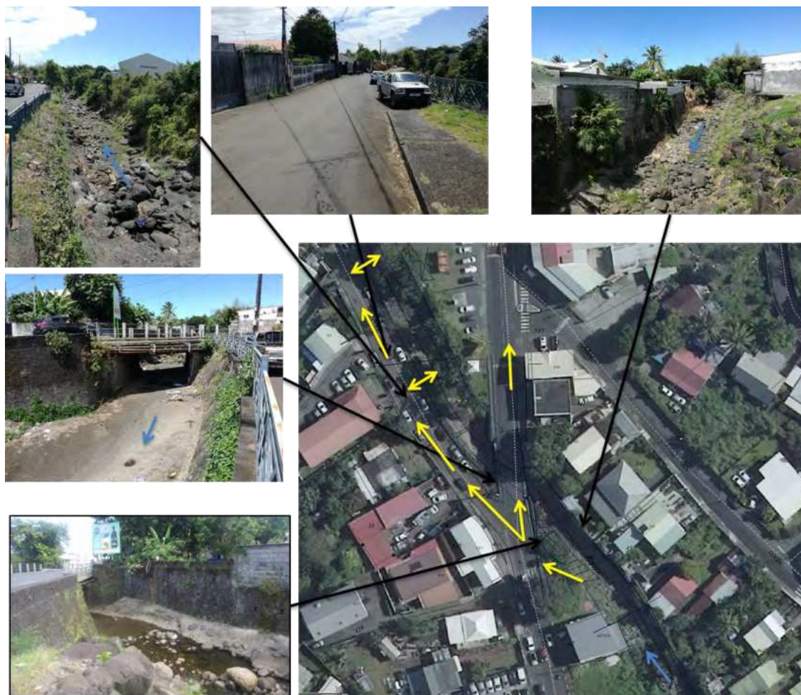
Fig. 48. Mécanismes de débordements – Pont Auguste
