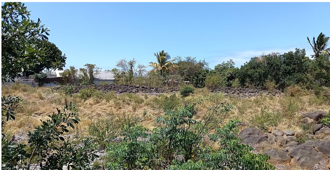
Figure 34 : Enrochements libres dans le bras principal au niveau de la quincaillerie
