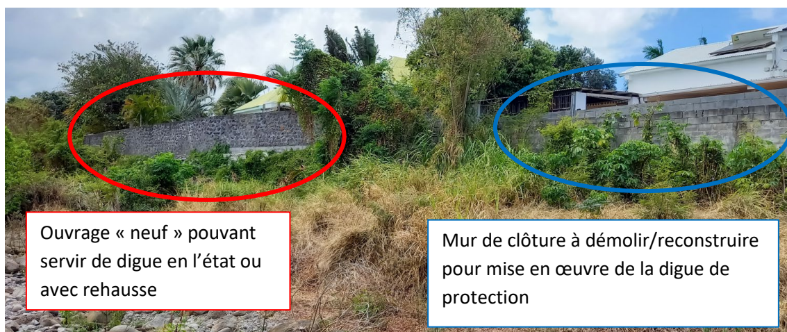
Figure 36 : Murs moellons « neuf » de clôture riverain en amont direct du radier existant – Bras principal
