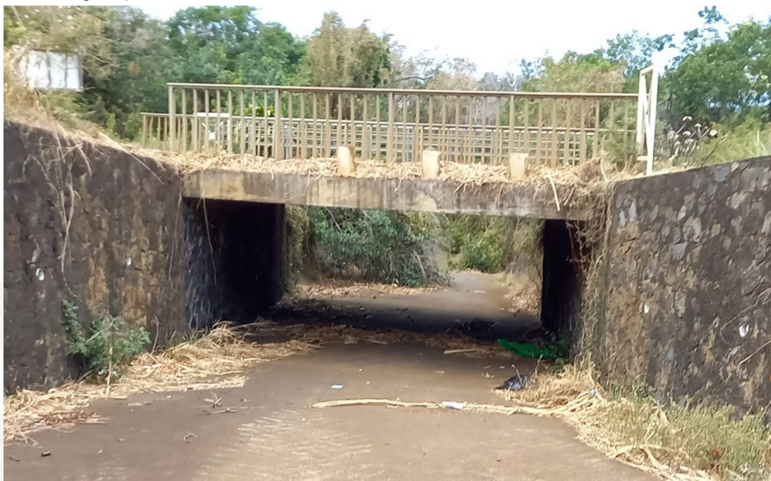
Figure 43 : Vue depuis l'amont sur l'ouvrage hydraulique
