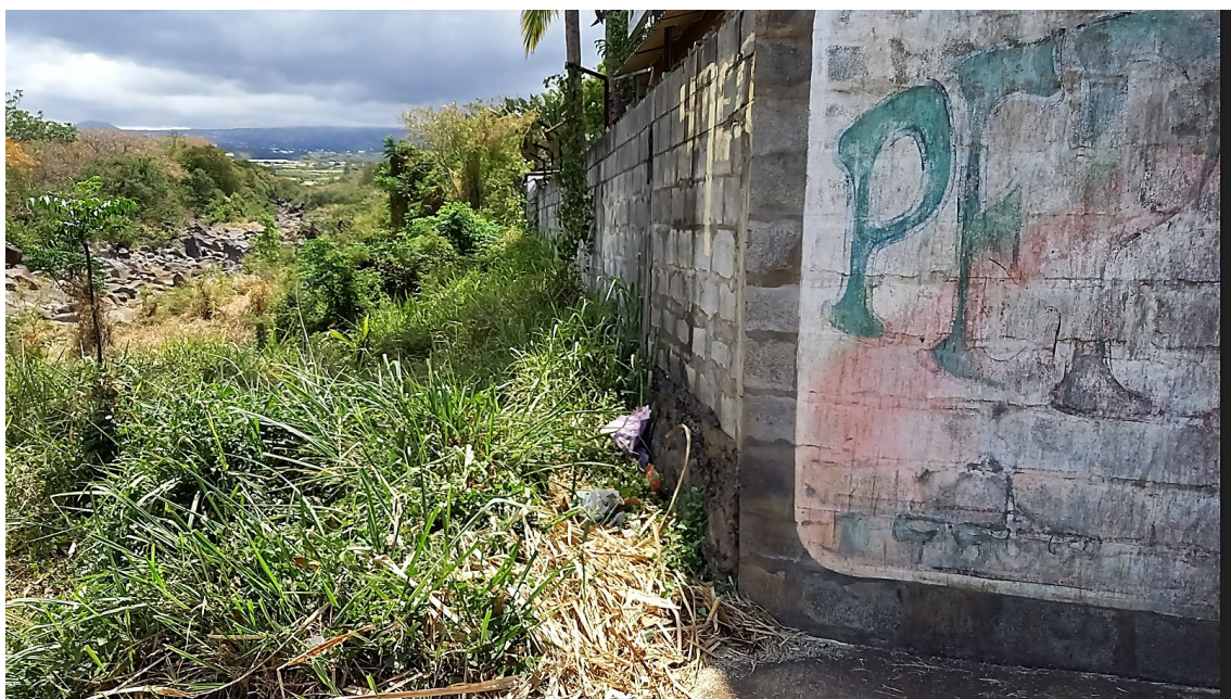
Figure 35 : Murs de clôture riverain en amont direct du radier existant – Bras principal
