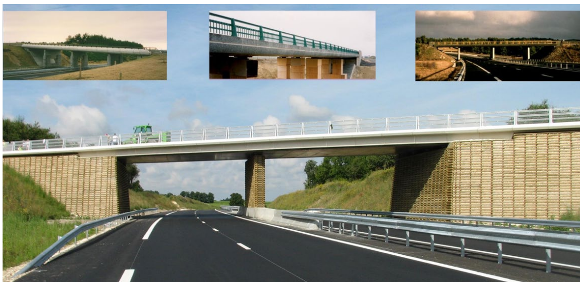
Figure 49 : Exemple de pont dalle béton armé (CEREMA)
