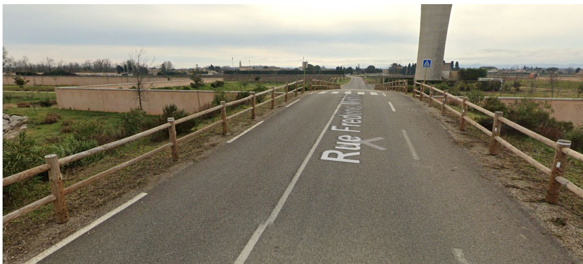
Figure 38 : Exemple de surélévation de la route traversante au niveau de la digue de protection – Codolet
