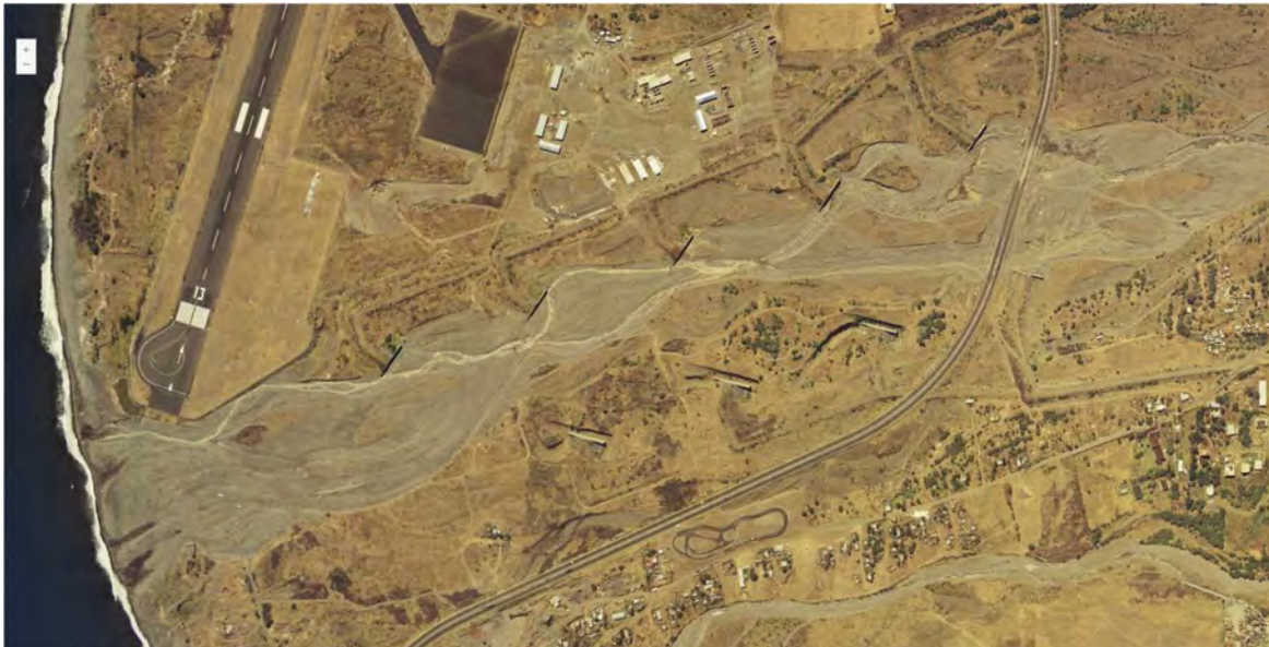
Figure 15 : Vue aérienne de 1973 montrant le système de protection par endiguement et épis marteaux construit sur le cours aval de la Rivière des Pluies (source IGN).
