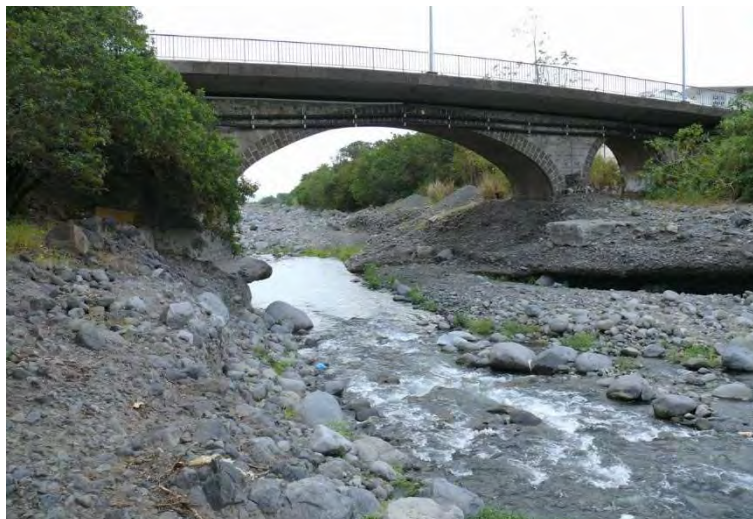
Figure 12 : Pont Domenjod, vu depuis l'amont (source Structurae)
