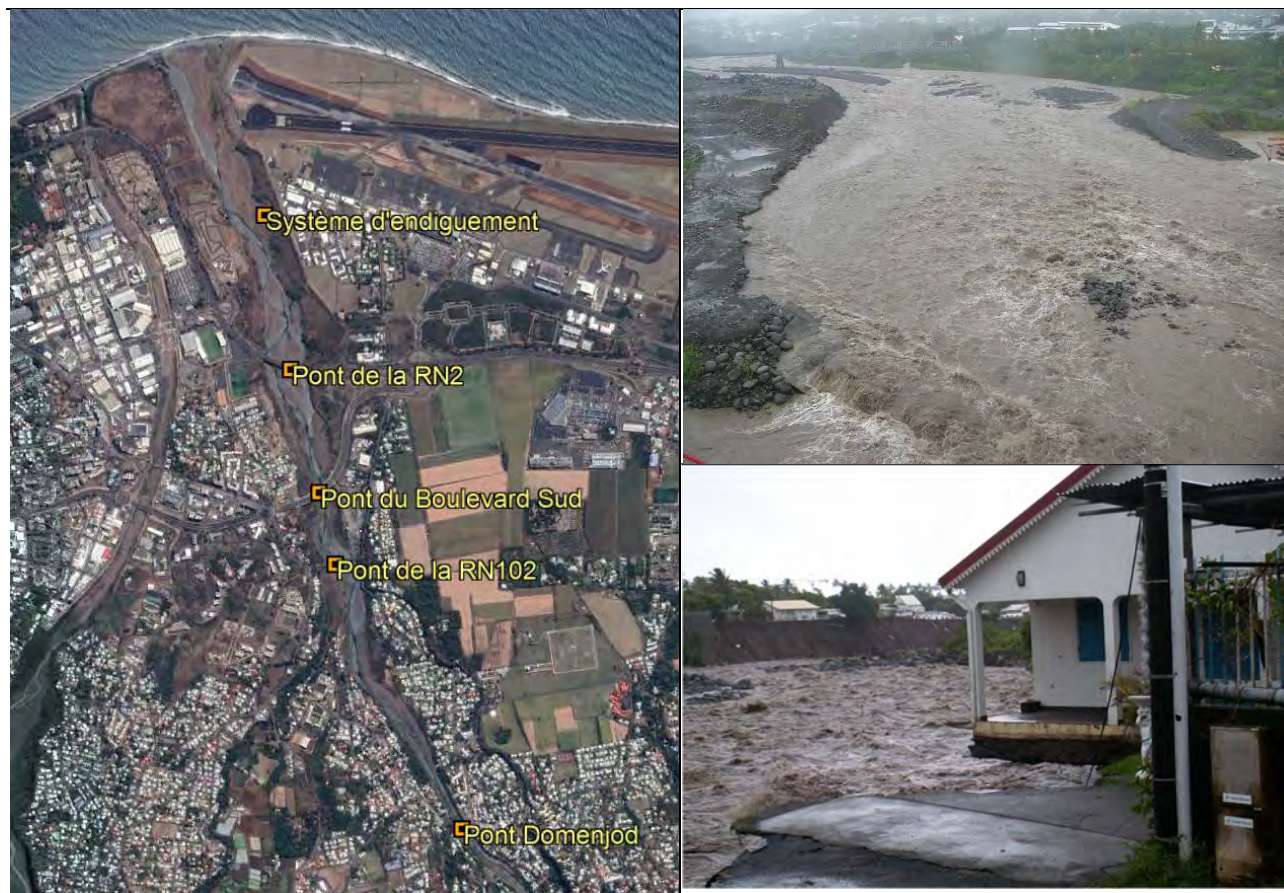
Figure 1: emprise du périmètre de l'étude (à gauche) et dynamique spécifique à l'hydraulique des écoulements de la Rivière des Pluies en période de crue (à droite).
