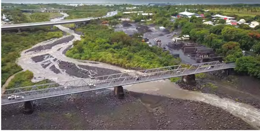
Figure 14 : Vue d'amont en aval, depuis l'amont, sur le Pont de la RN102 (Pont métallique ou Pont Neuf), le Pont du Boulevard Sud et le Pont de la RN2 (pont de Gillot) lors d'une petite crue intervenue en 2018.
