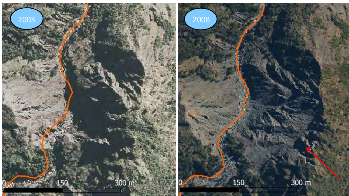
Figure 32 : Effondrement de la rive droite au niveau du tronçon FJ1 suite aux cyclones Diwa et Gamède (2006 et 2007)
