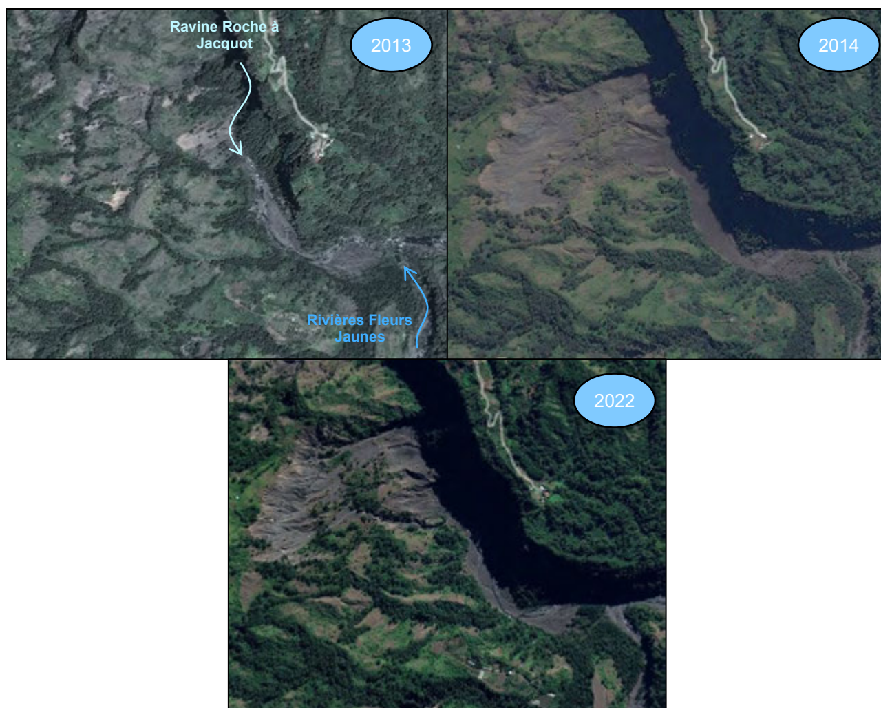
Figure 83 : Avalanche de débris en aval de la Ravine Roche à Jacquot lors du cyclone Bejisa (2014) – (Source : Google Earth)
