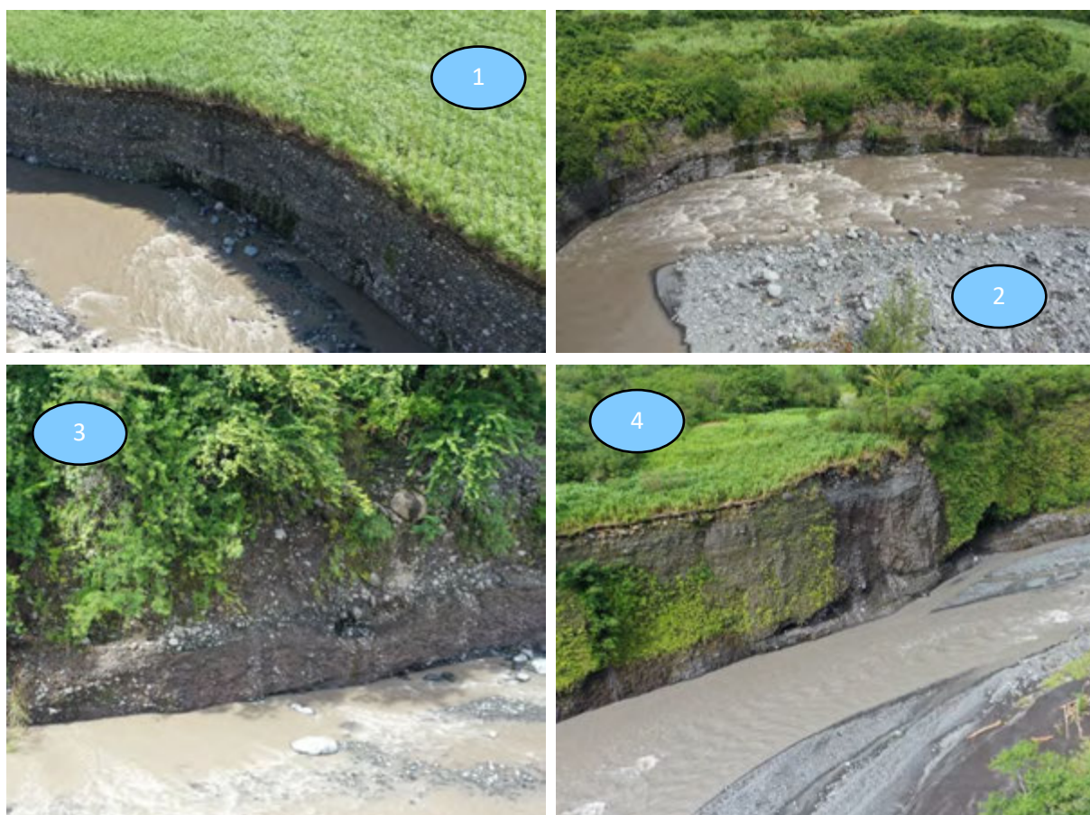
Figure 98 : Erosions des terrasses alluvionnaires anciennes (1 : rive gauche tronçon M6 aval ; 2 : rive droite tronçon M6 ; 3 : rive droite tronçon M6 ; 4 : rive droite tronçon M5, sapement de pied de berge bien visible (Ilet Payet))
