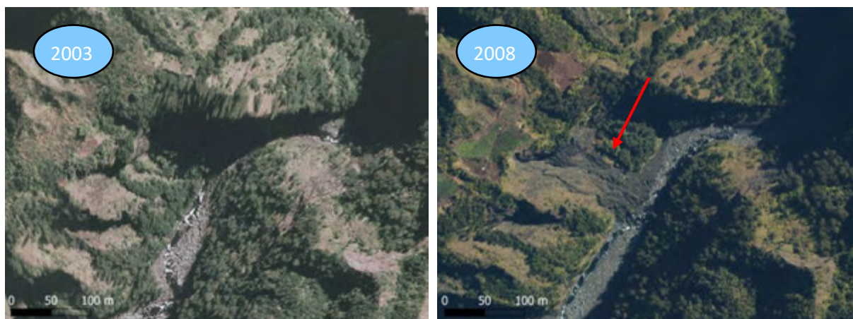
Figure 34 : Glissement de terrain sur la Rivière des Fleurs Jaunes (tronçon FJ3)
