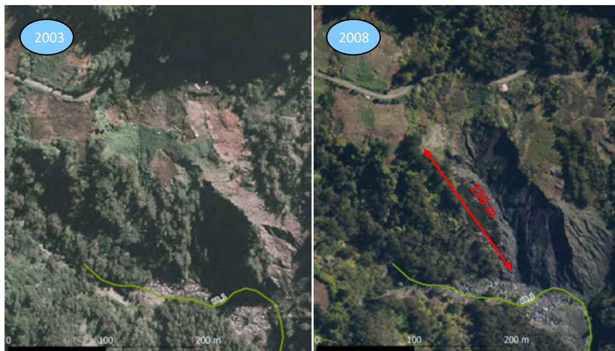
Figure 30 : Glissements de terrain en rive gauche de la Ravine Blanche sur 150m entre 2003 et 2008
