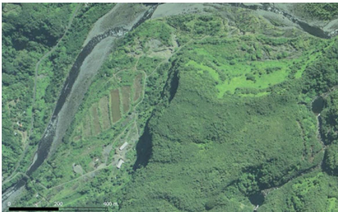
Figure 17 : Extractions de matériaux à l'ilet Payet (1997)
