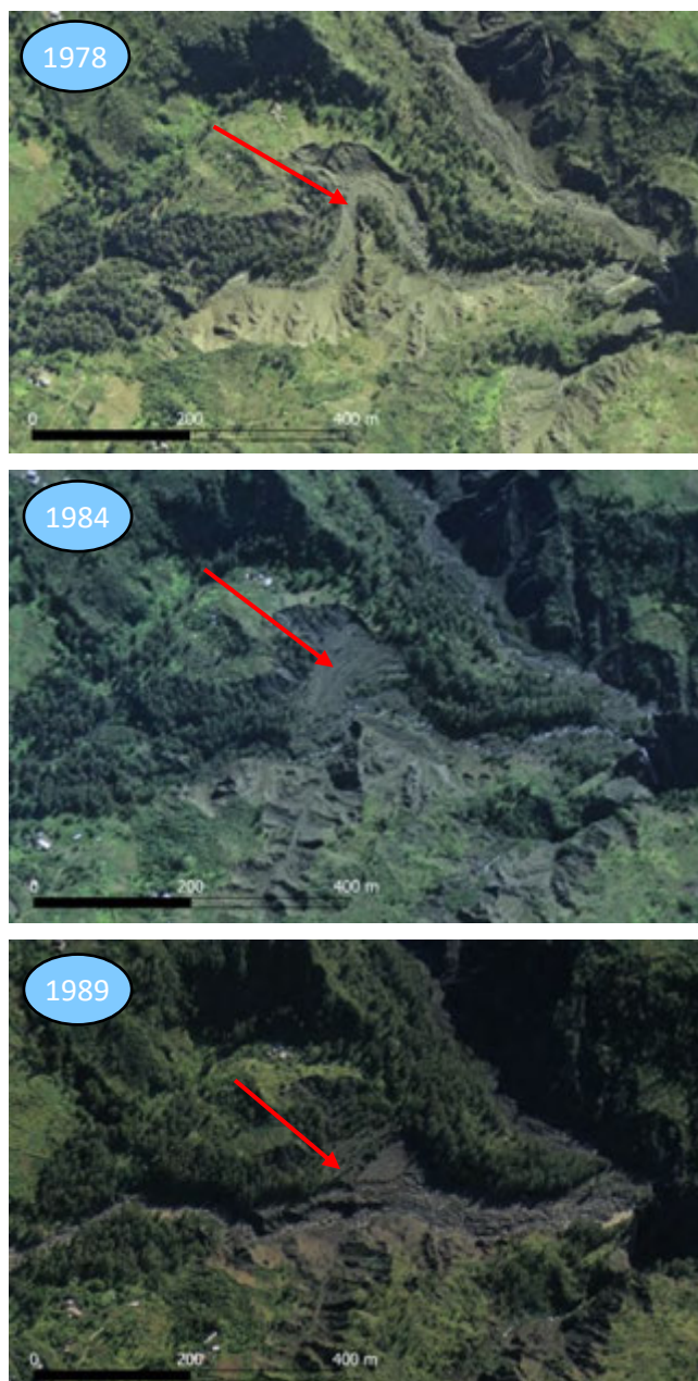
Figure 25 : Erosion de l'éperon rocheux sur la Ravine Roche à Jacquot entre 1978 et 1989
