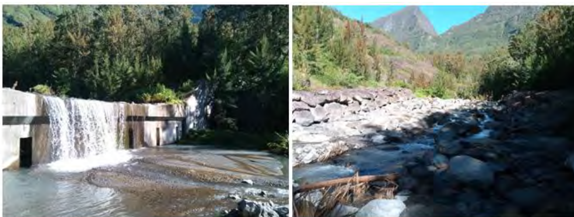
Figure 21 : Barrage et enrochements libres sur la ravine Roche à Jacquot
