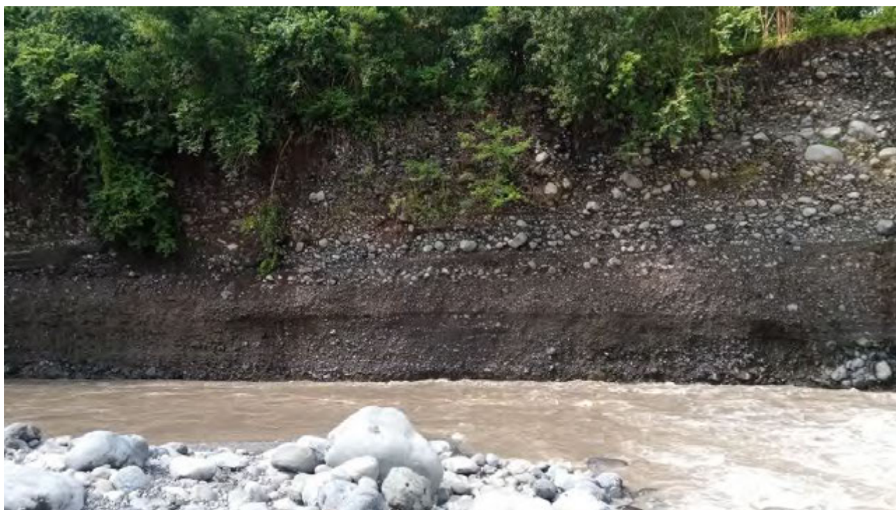
Figure 97 : Erosion en aval du pont de la RN2 (M6) avec granoclassement des matériaux
