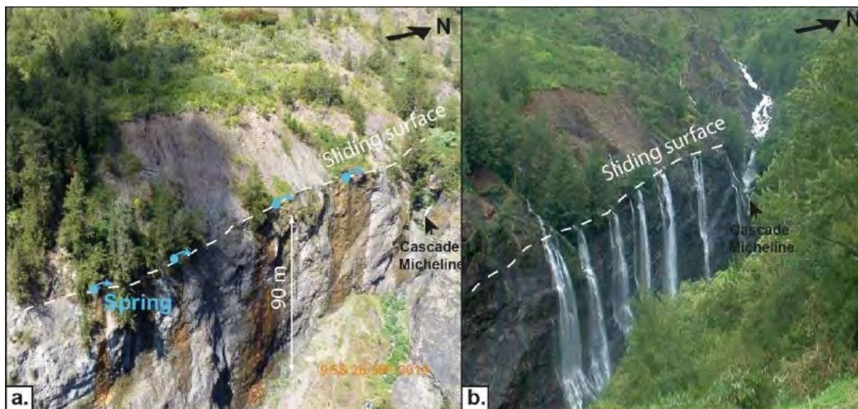
Figure 79 : Limite entre le glissement et le substratum sur le front du glissement de Grand Ilet. Des sources sortent au contact de ses formations durant la saison cyclonique ou après des précipitations. Sous la limite de glissement, les matériaux sont cohérents et cohésifs, au-dessus les matériaux sont non cohérents (source : BRGM)
