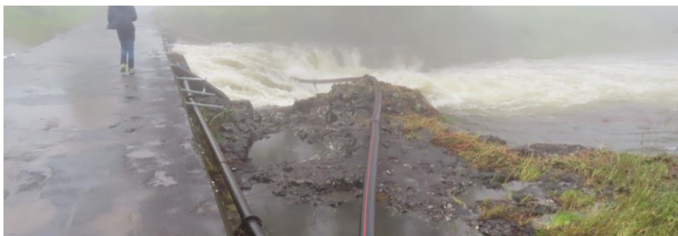
Illustration 12 : Des réseaux électriques arrachés lors du cyclone Batsirai 2022
