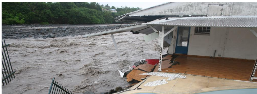
Illustration 33 : Destruction d'une habitation au bord de la rivière des Pluies lors du cyclone Diwa 2006
