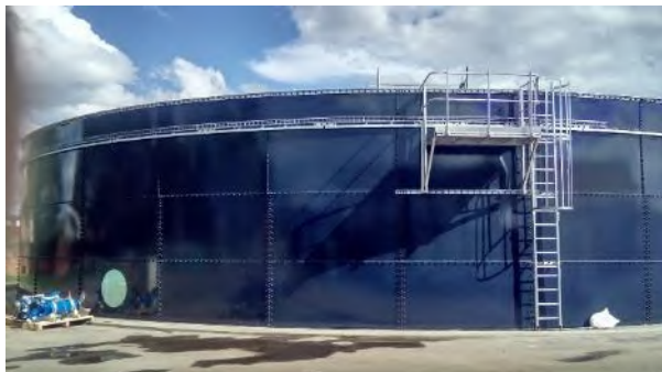
Revamping STEP textile 2500 m 3 /j - COTONA Antsirabe Bassin acier vitrifié 2800 m 3 , coagulation, floculation, centrifugeuse à boues
