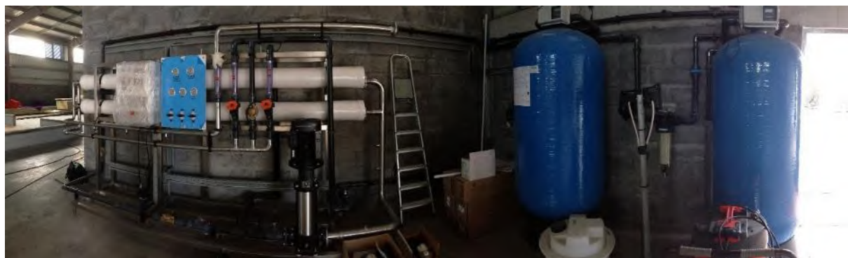
Conception et fabrication d'une unité d'osmose inverse 8m 3 /h – Royal Bourbon Industries
