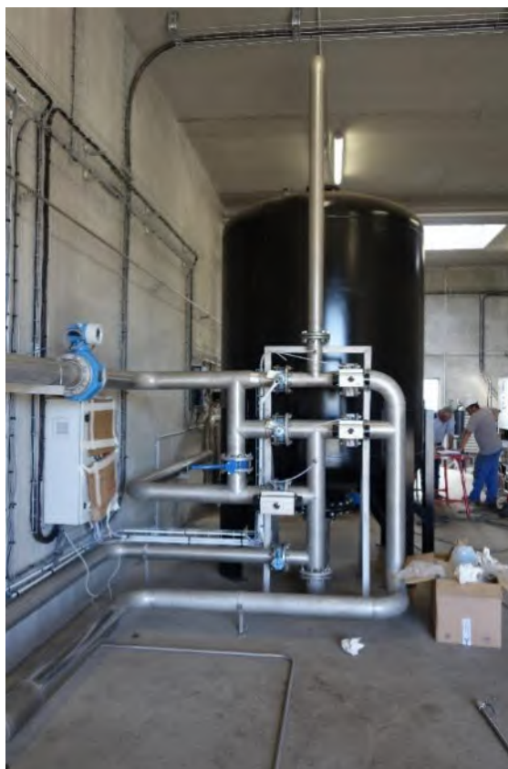
Conception et fabrication d'un filtre bicouche 40m 3 /h – Crête d'Or
