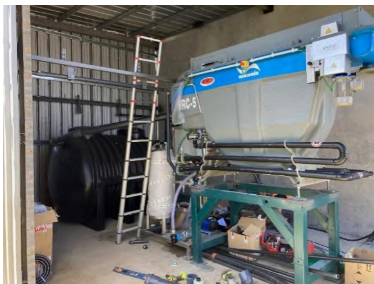
Installation d'un flottateur à air dissous + coagulation/floculation – STS
