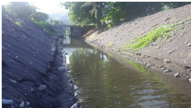
Figure 1 - Vue de l'aval vers l'amont de la station 1.
