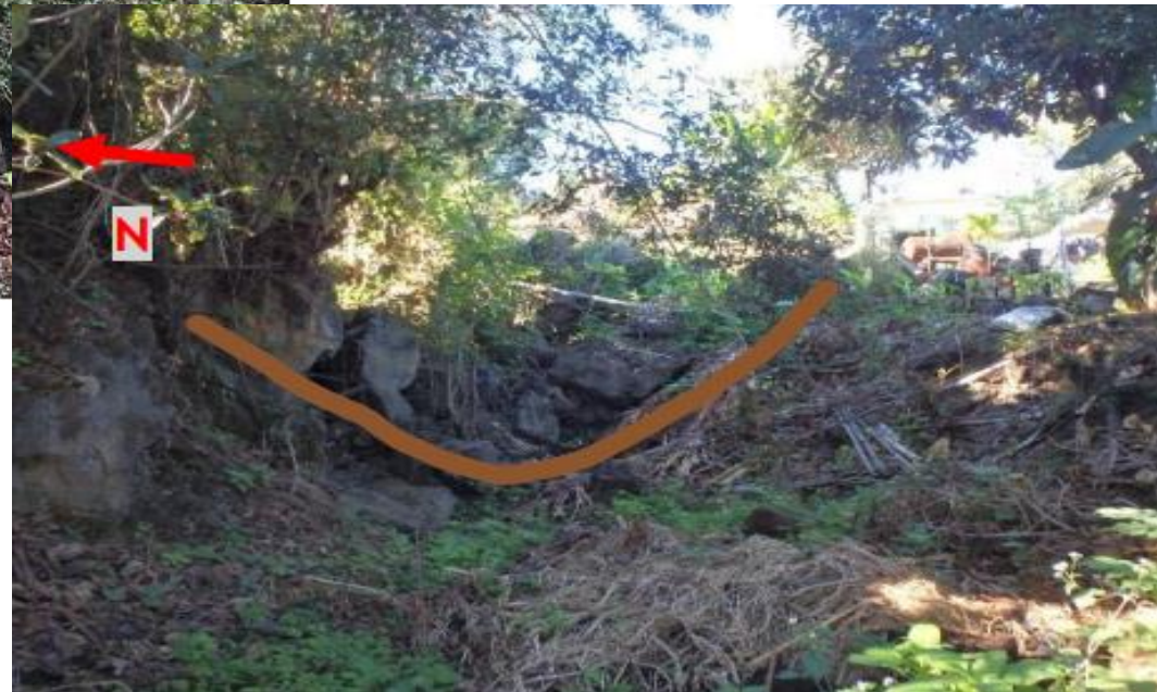
Blocs basaltiques et dalle de béton obstruant le lit mineur
