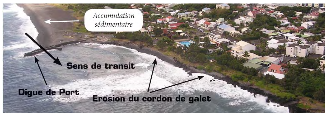
Figure 18 – Exemple de digue bloquant le transit sédimentaire à Saint-Benoît (De La Torre et al, 2012)
