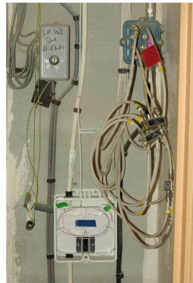
Colonne montante : de gauche à droite, réseau téléphonique, réseau optique (PBO) et coaxial TV.
