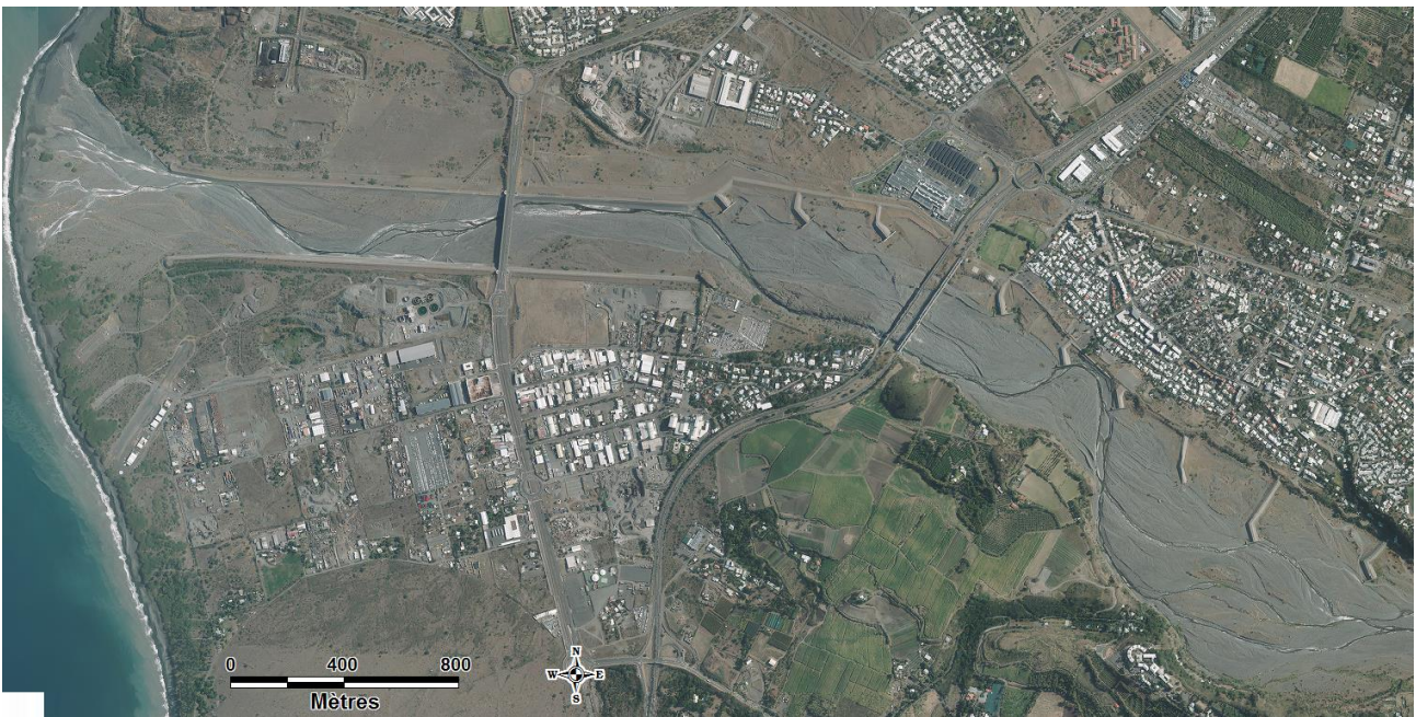
Figure 5 : La Rivière des Galets et ses ouvrages d'endiguement (orthophotos IGN© 2011)
