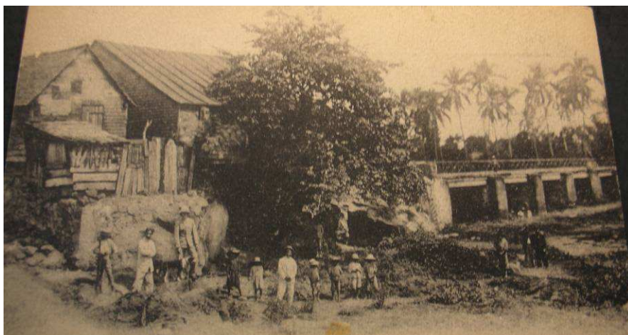
Figure 39 : Entrée du village, pont et emplacement du lavoir actuel à la Grande Fontaine. Source : Ancienne collection Younouss
