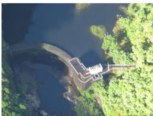
**Barrage voûte à crête déversante de la prise hydroélectrique EDF de Takamaka 1 (rivière des Marsouins)**
