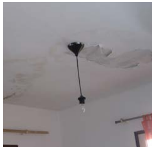
Traces d'infiltration
